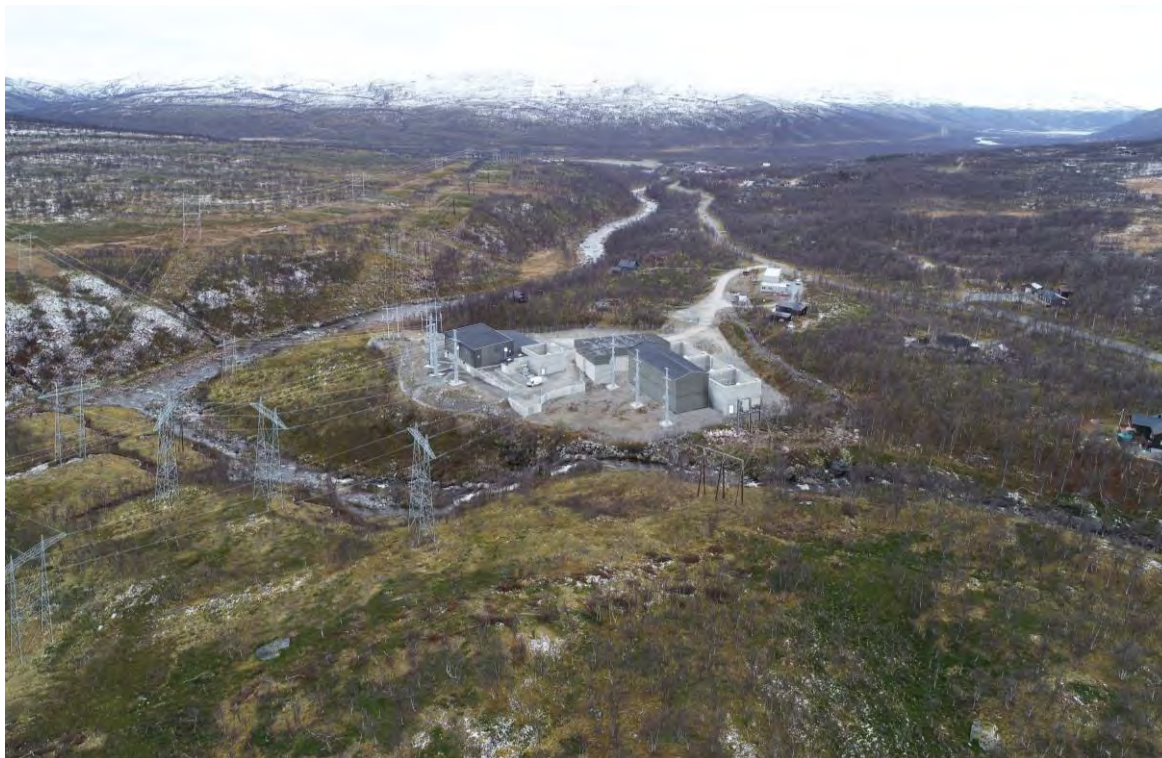
Figur 8-6. Fotovisualisering av nytt 420 kV GIS anlegg ved Skaidi transformatorstasjon med inn- og utføring ledninger. Fotovisualisering: Multiconsult/Eva Hjerkin. Foto: Statnett SF.
