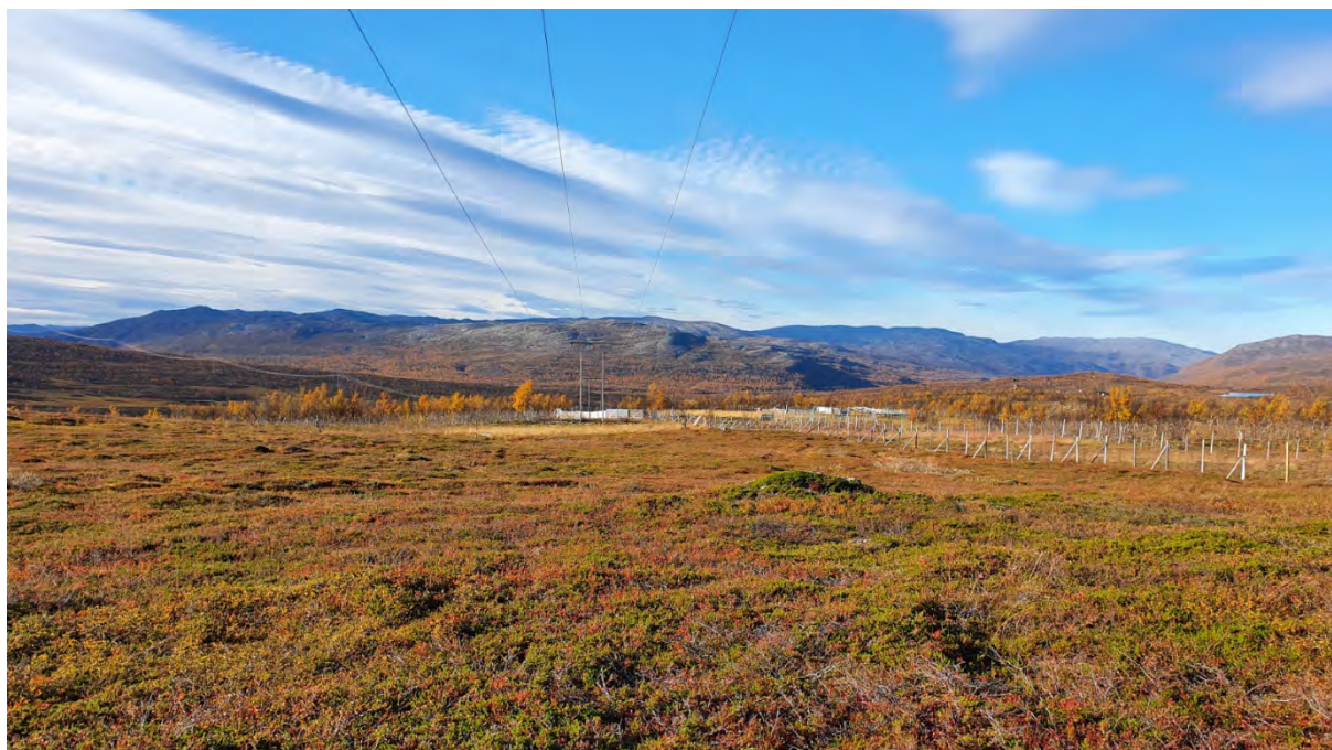
Figur 16: Foto av 66 kV traseen med gjerdeanlegg for rein like nordøst for Skaidi transformatorstasjon
