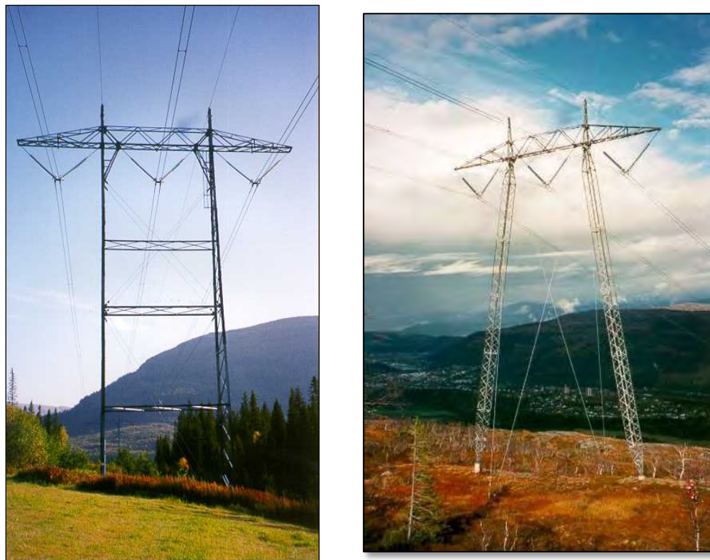
Figur 3: Bilder av aktuelle mastetyper for 420 kV ledning, til venstre selvbærende stålmas, til høyre utvendig bardunert mast (M-mast).
