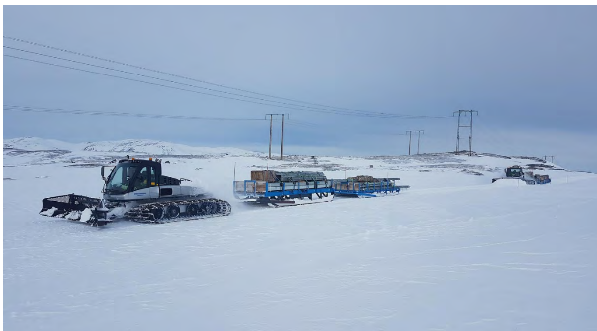
Figur 35: Vintertransport av mastemateriell. Her fra bygging av ny 420 kV ledning mellom Balsfjord og Skillemoen.
