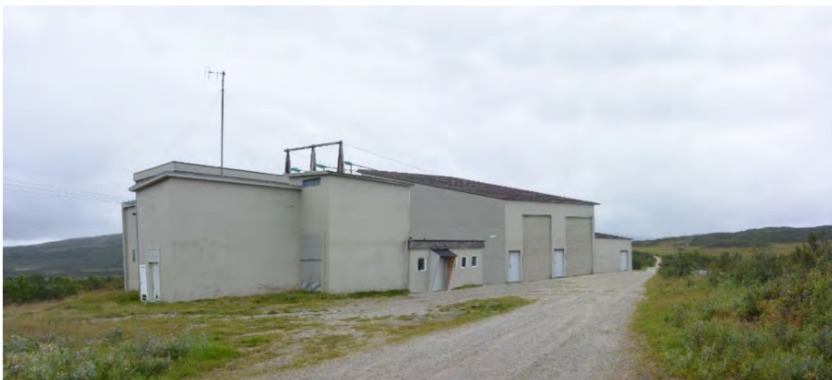
Figur 30: Fotomontasje av Smørfjord stasjon med utvidelse mot sørvest. Fasader planlegges utført på samme måte som dagens stasjon.
