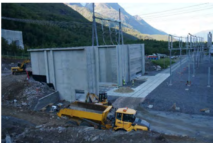
Figur 25: Eksempel på transformatorsjakt i betong
