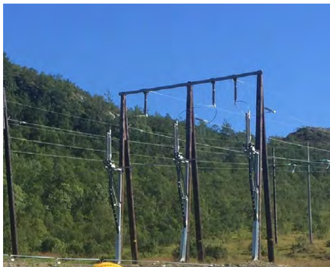
Figur 41: Eksempel på en 132 kV kabelendemast.
