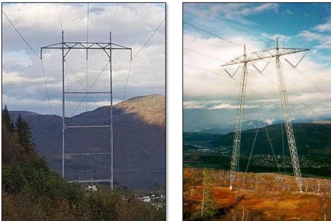
Figur 4. Bilder av aktuelle mastetyper, til venstre selvbærende 132 kV stålmaster, høyre: utvendig bardunert mast (M-mast).
