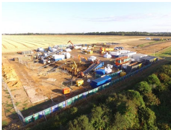
Figur 26: Riggplass for boring av mikrotunneler krever store arealer
