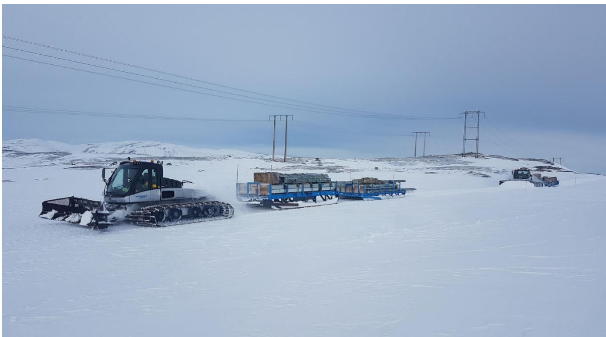
Figur 16: Vintertransport av mastemateriell. Her fra bygging av ny 420 kV ledning mellom Balsfjord og Skillemoen.
