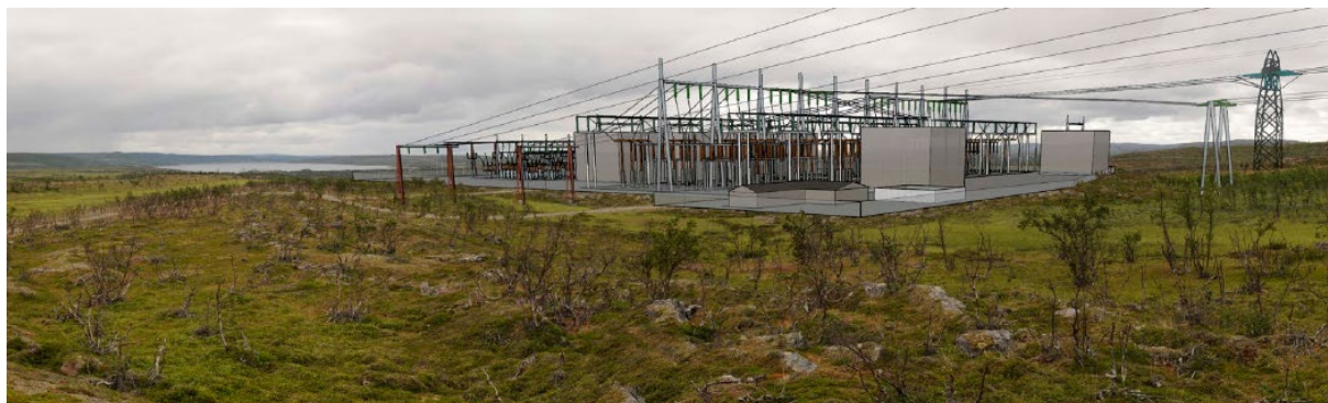
Figur 20: Fotomontasje av Varanger B. Foto av stasjonen tatt mot øst, Varangerfjorden ses i bakgrunnen.
