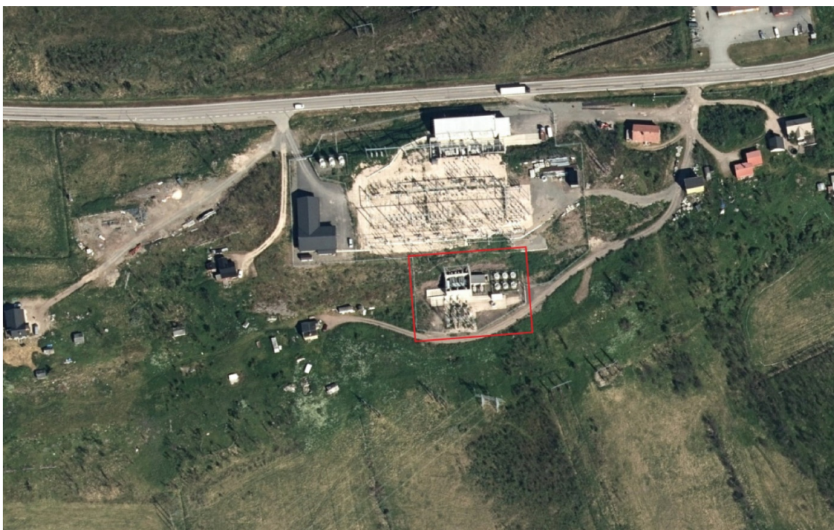
Figur 5: Flyfoto av Varangerbotn transformatorstasjon, rødt rektangel viser 220 kV anlegget som vil bli revet.
