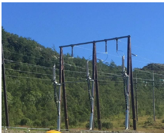
Figur 29: Eksempel på en 132 kV kabelendemast.
