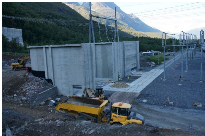
Figur 7: Eksempel på transformatorsjakt i betong
