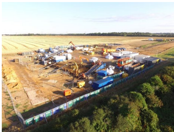
Figur 27: Riggplass for boring av mikrotunneler krever store arealer
