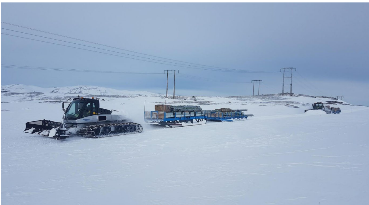
Figur 17: Vintertransport av mastemateriell. Her fra bygging av ny 420 kV ledning mellom Balsfjord og Skillemoen.
