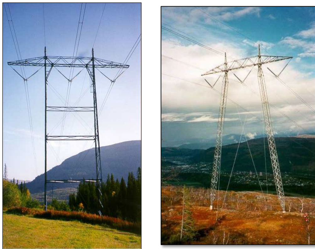
Figur 11: Bilder av aktuelle mastetyper for 420 kV ledning, til venstre selv bærende stålmast, til høyre utvendig bardunert mast (M-mast).
