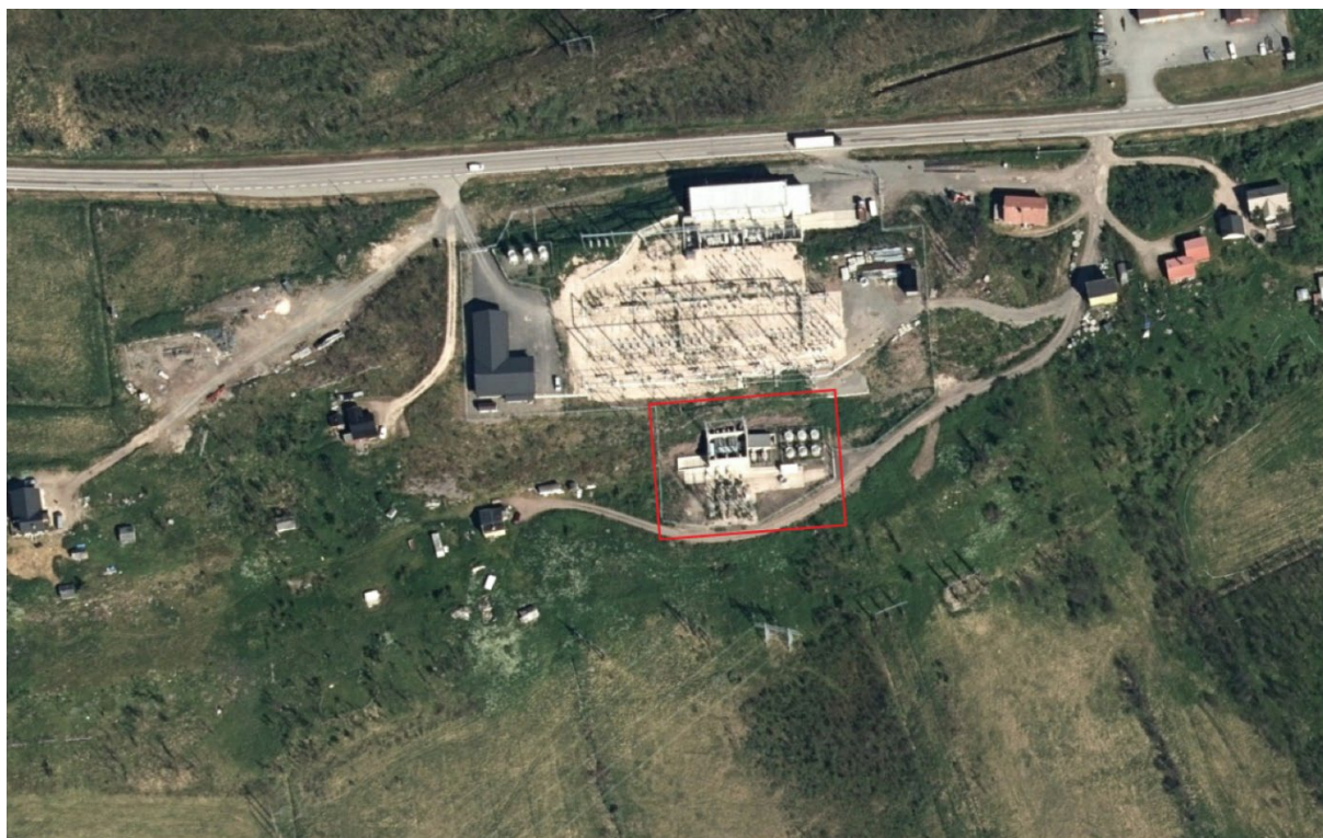
Figur 5: Flyfoto av Varangerbotn transformatorstasjon, rødt rektangel viser 220 kV anlegget som vil bli revet.
