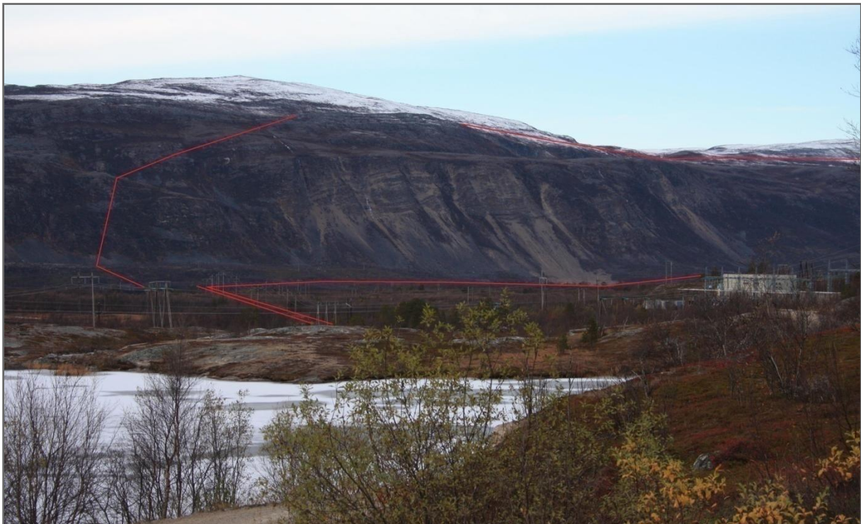
Figur 10: Lakselv transformatorstasjon. Bilder er tatt mot vest på veien opp mot leirstedet Karalaks som ligger ca 800 m øst for stasjonen. Dagens transformatorstasjon sees til høyre i bildet. Planlagt ny stasjon er tenkt lokalisert midt i bildet i nær tilknytning til dagens stasjon. Med rød strek er vist alternative ledningsføringer mot Skaidi. Alternativ 1.2 er lag oppe på fjellet mens alternativ 1.0 ligger parallelt med dagens ledninger i lifoten.
