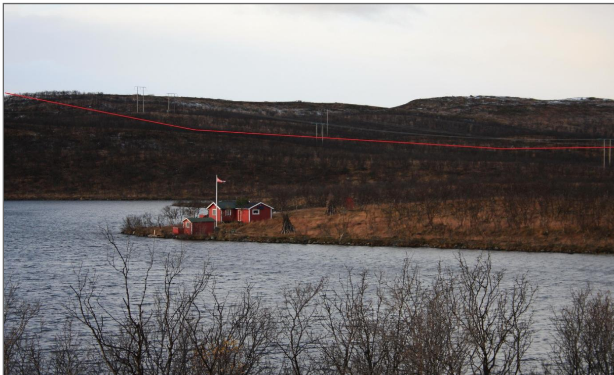
Figur 21: Rovvejavri i Nesseby kommune. Bildet er tatt mot nord. I bakgrunnen sees dagens to 132 kV kraftledninger Tana bru – Varangerbotn og Adamselv - Varangerbotn. Ny 420 kV-ledning er tenkt lagt parallelt med disse.
