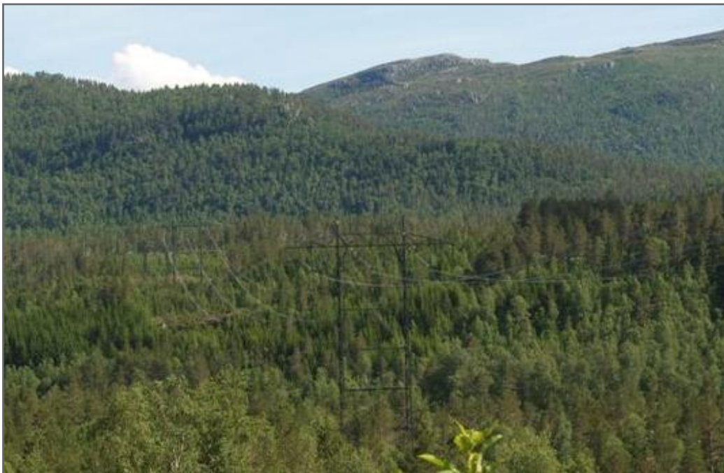
Figur 25: Bilde av kamouflert kraftledning. Her er mastene malt mørk olivengrønn for å etterligne skyggene i terrenget. Linene er mattet og isolatorene som holder linene til masta, er av kompositt i stedet for av glass som er det normale.
