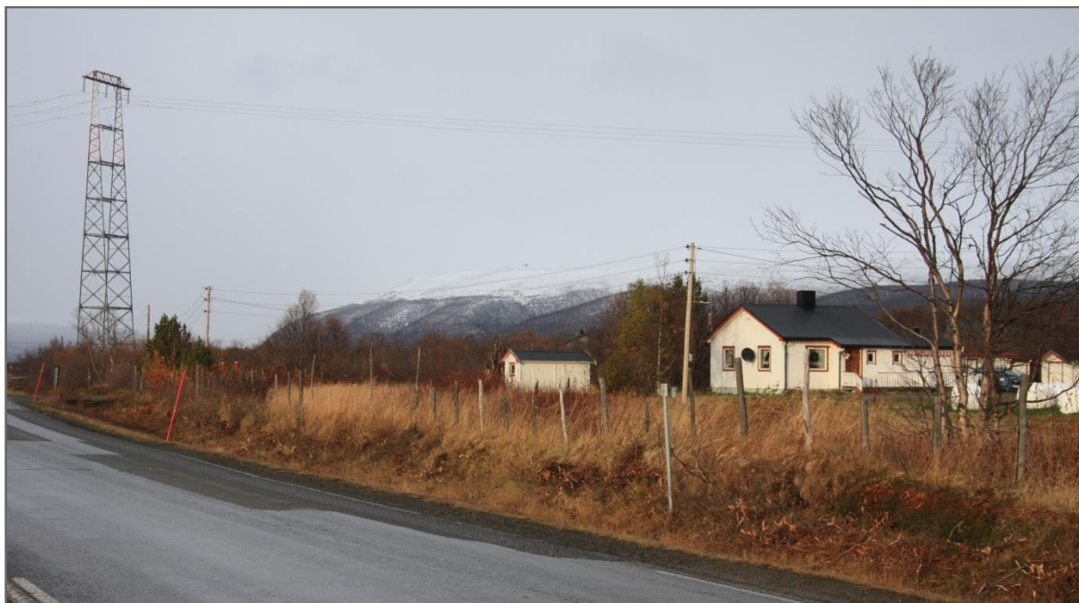
Figur 24: Bildet viser eksisterende boligbebyggelse i nærheten av dagens 132 kV-ledning Adamselv – Varangerbotn på østsiden av Tanaelva. Dersom ny ledning legges parallelt med dagens ledning vil avstanden fra ledningens senterlinje til nærmeste bolig bli ca 50 m. Det ligger flere boliger i dette området. Det er bebyggelse på begge sider av dagens ledning.
