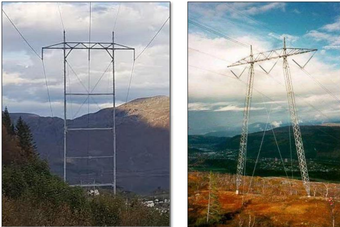
Figur 2-8. Bilder av aktuelle mastetyper, til venstre selvbærende stålmaster (portalmast), høyre: innvendig bardunert mast (M-mast).
