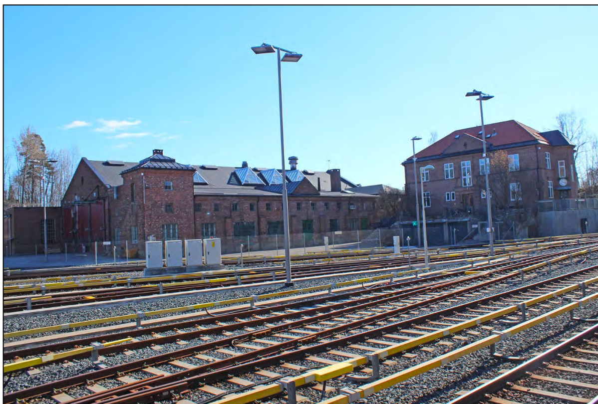
Avløs stasjon. Foto: Jan Adriansen, Sweco
