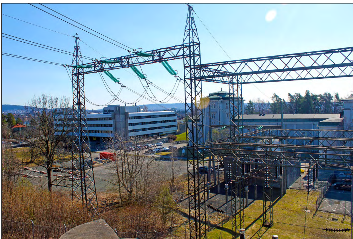
Transformatorstasjonens bygning fra 1921 til høyre i bildet, det yngre kontorlokalet til venstre. Foran kommer 300 kV Hamang – Smestad inn. Foto: Jan Adriansen, Sweco.
