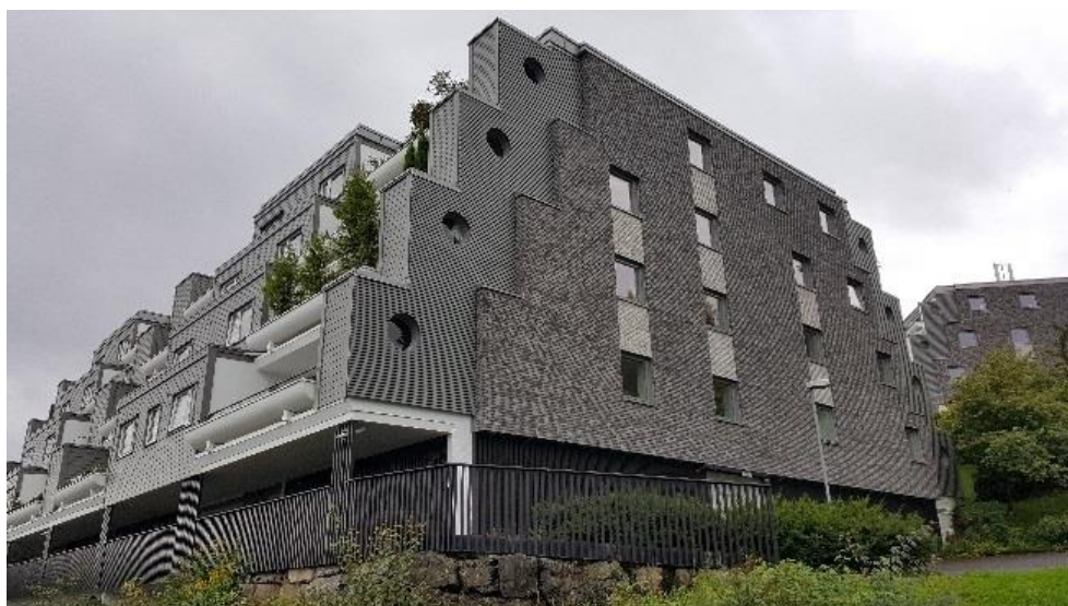
Figur 1-19 En av boligblokkene i Øvre Myrveien som er listeført av Byantikvaren. Foto: M. M., Sweco, august 2017.
