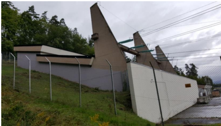
Figur 1-4 Bærum trafo. Foto: M. M., Sweco, august 2017.
