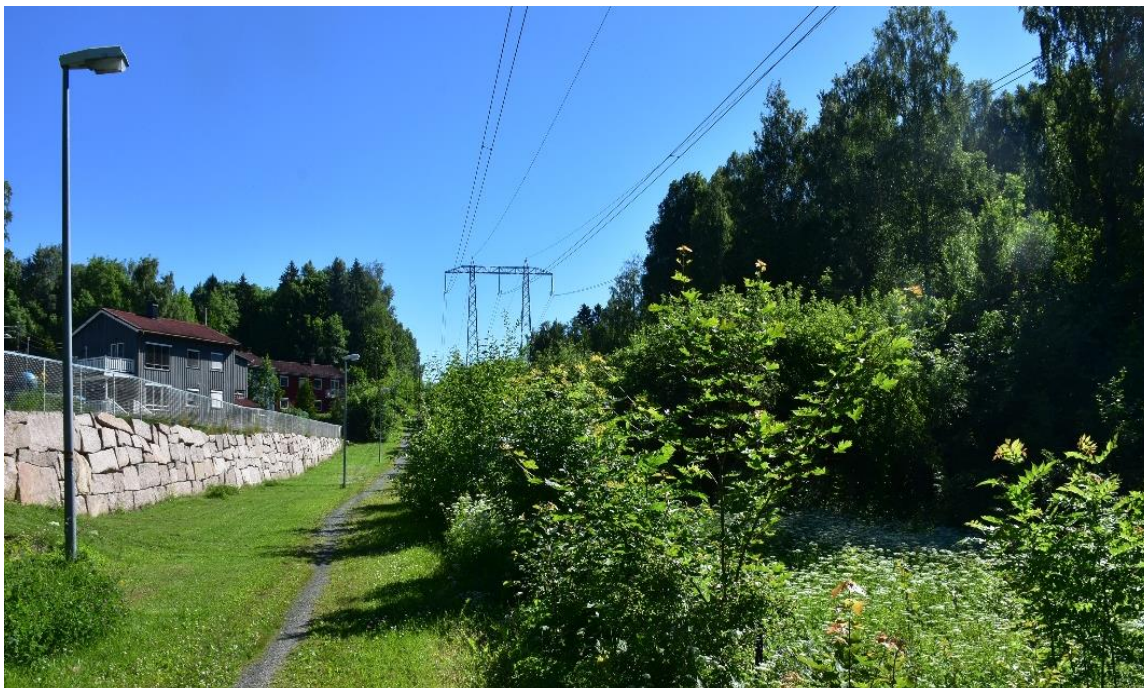
Figur 1-8. Like øst for Hamang Trafo passerer dagens ledning gamle hager som gror igjen. Foto: Sweco Norge.
