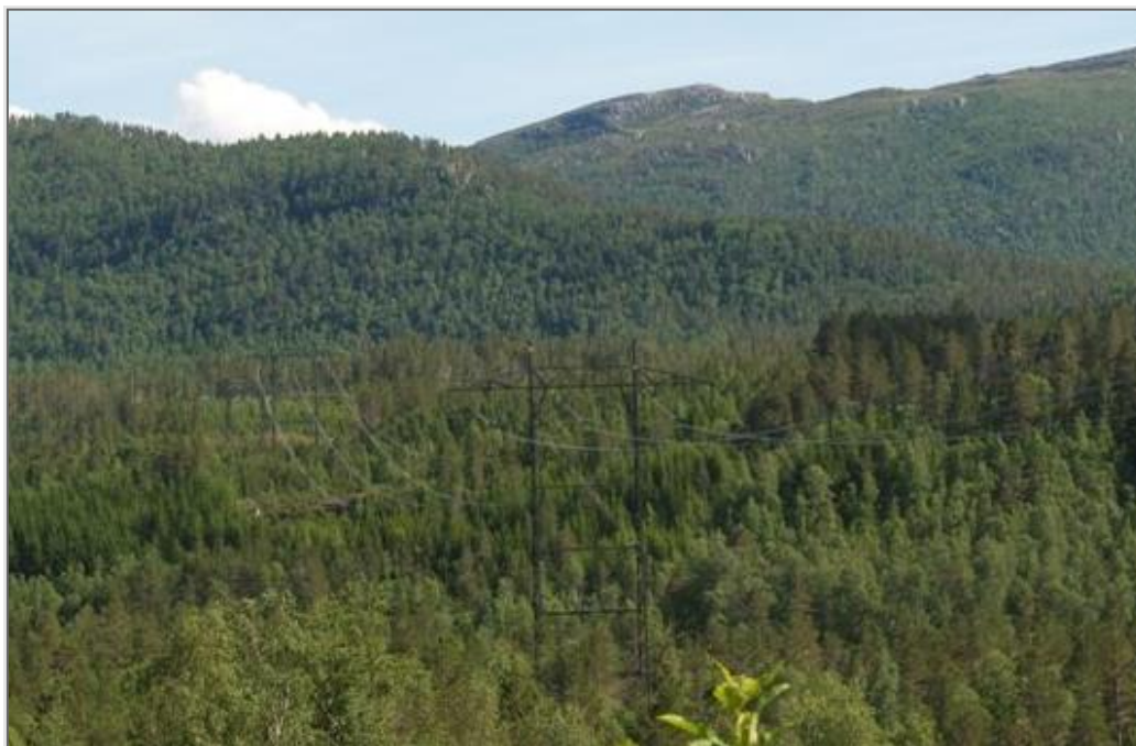
Figur 14: Bilde av kamuflert kraftledning. Linene er mattet, og isolatorene er av kompositt i stedet for av glass som er vanligst å benytte.
