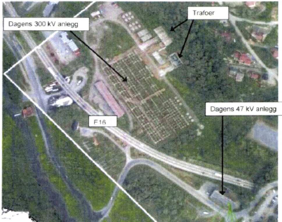
Figur 1: Dagens situasjon. Hamang transformatorstasjon og omkringliggende områder (kilde: Statnett, den hvite streken er bare et teknisk skille mellom to foto lagt oppå hverandre i Statnetts database)
