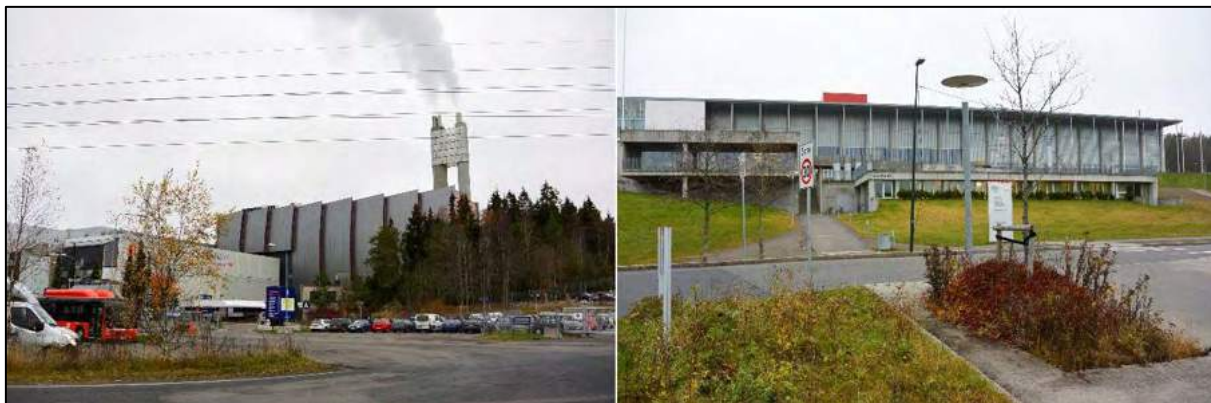
Figur 4-10. Området er preget av nærings- og industribebyggelse. Bildet til venstre viser energigjennvinningsanlegg på Klemetsrud. Bildet til høyre viser Bjørnholt Videregående Skole. Foto: E. Hjerkin, Multiconsult.
