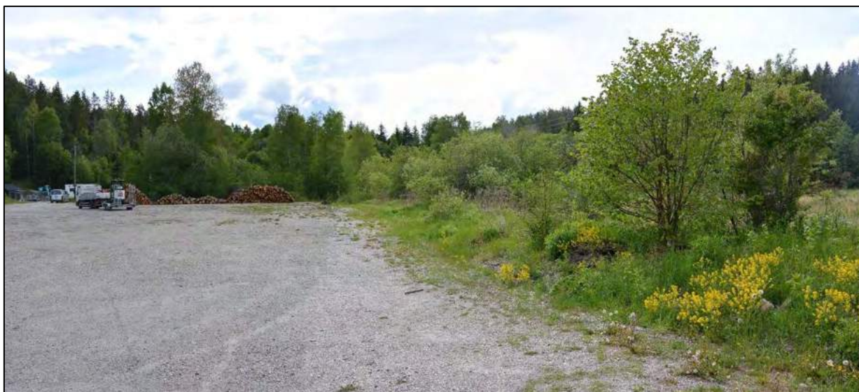
Figur 4-19. Utsikt fra utfartsparkeringen sør i delområdet. Det nye anlegget sprenges inn i bergformasjonen som ligger i bakkant til høyre i bildet. Det vil være en del skogsvegetasjon i området som vil begrense innsynet til transformatorstasjonen. Foto: E. Hjerkin, Multiconsult.
