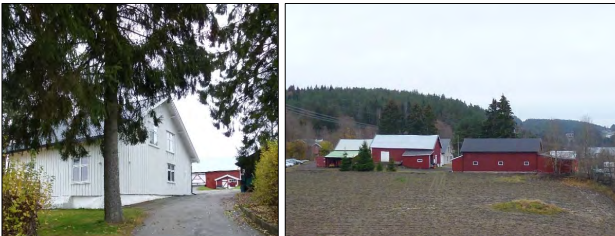
Figur 7-2. Nordli, listeført bolig og driftsbygning fra sør og nord. Foto: V. Berge, Multiconsult
