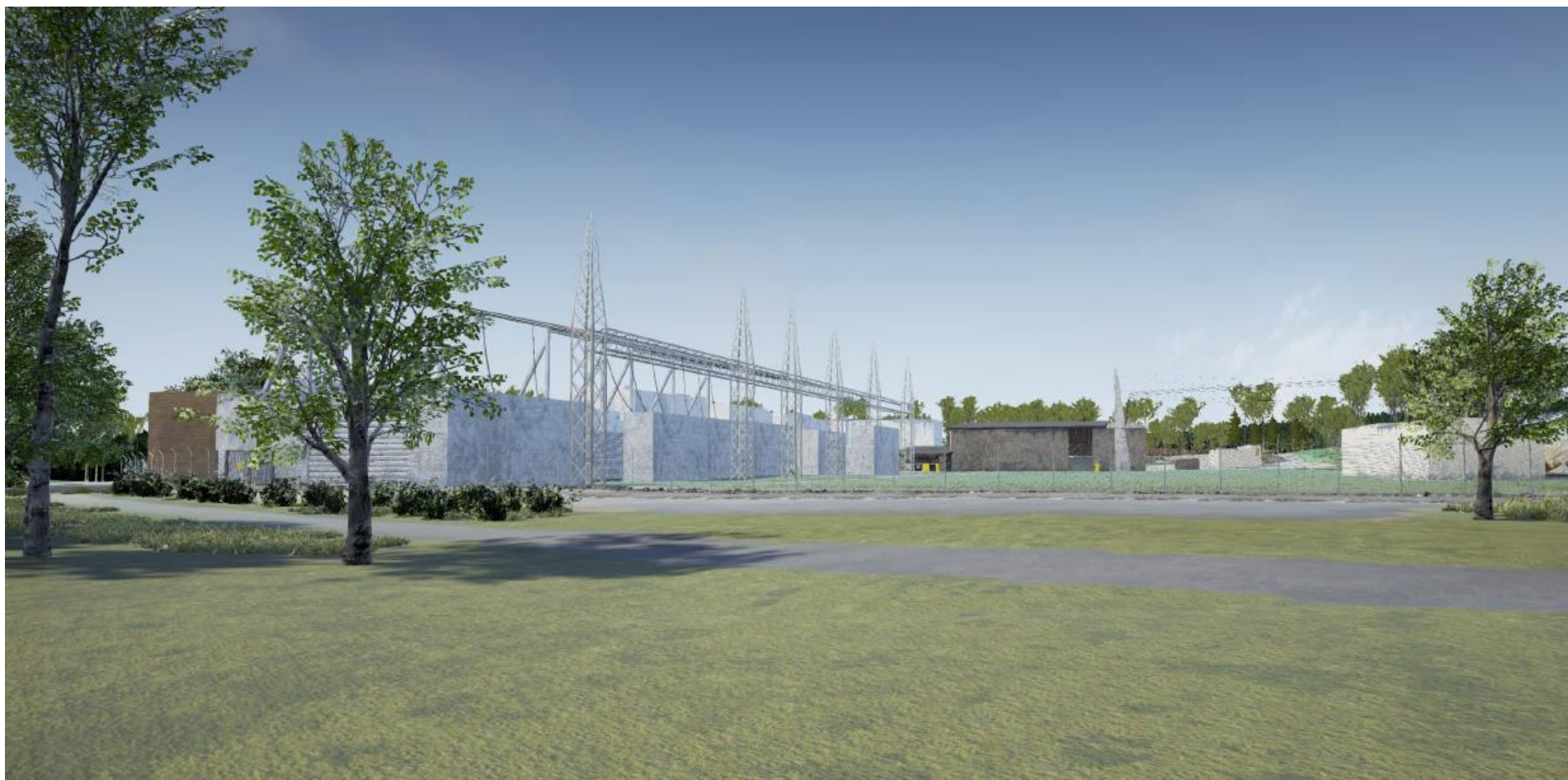
Figur 2. Bildet er tatt fra øst mot vest. Det meste av eksisterende friluftsanlegg er revet. Nye muffehus er til venstre i bildet, mens selve SF 6 -bygget vises som et mørkegrått bygg midt i bildet.
