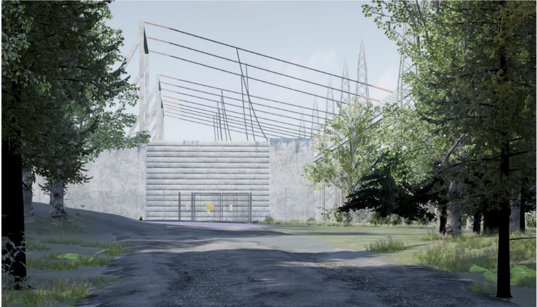
Figur 1. Bildet viser anlegget sett fra adkomstvei gjennom hagebyen (Nordbergveien). Det vil si stasjonen sees fra øst mot vest. Det foreslås satt opp en ny vegg og muffer for kabelender. Videre fremkommer innstrekking til transformatorer stort sett er lik de som er i dag.
