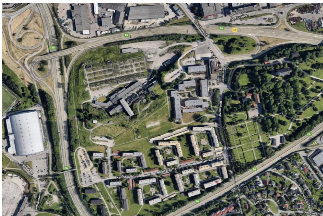
Figur 12: Oversiktsbilde over Ulven, og boligområdene sør og øst for transformatorstasjonen.
