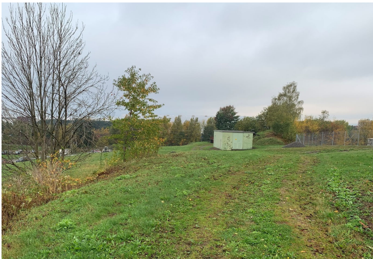
Figur 8 Bilde tatt vestover fra plataet rett bak eksisterende transformatorstasjon. Trærne rett bak det grønne bygget må hogges.
