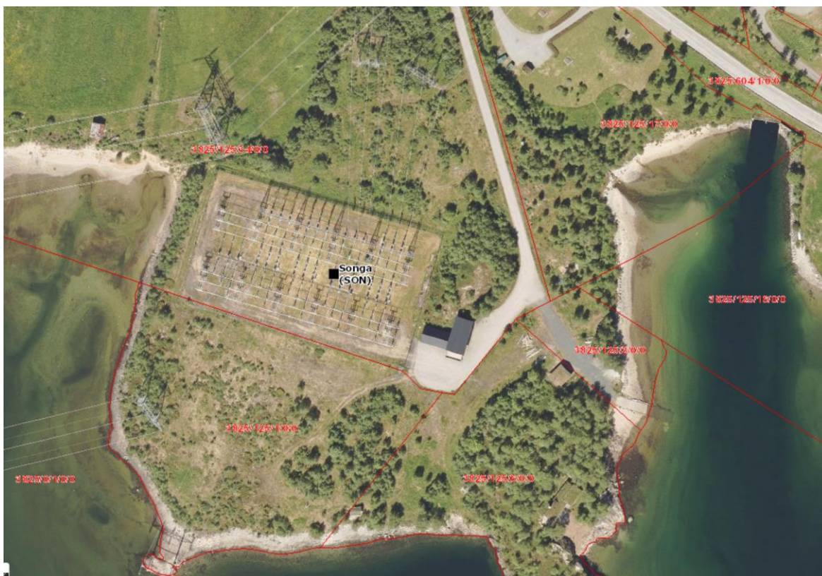
Figur 1. Ortofoto av eksisterende Songa koblingsanlegg.
