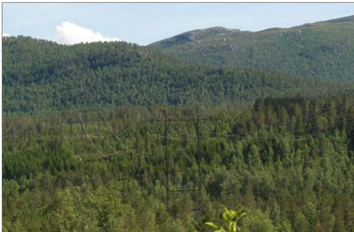
Figur 21 Bilde av kamouflert kraftledning. Linene er mattet, og isolatorene er av kompositt i stedet for av glass som er vanligst å benytte.
