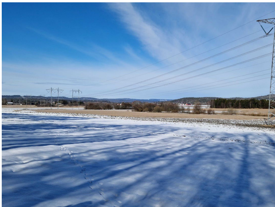
Figur 8 Eksisterende 300 kV og 420 kV mellom Tveiten og Rød. Bildet er tatt nord av Gullåsen. Bilde: Sweco Norge AS.
