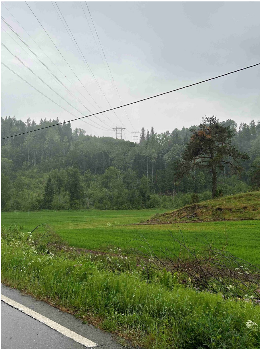
Figur 17 Eksisterende 300 kv og 420 kv sett fra Holtebygdveien i Larvik kommune. Ledningene føres over et kupert terreng.
