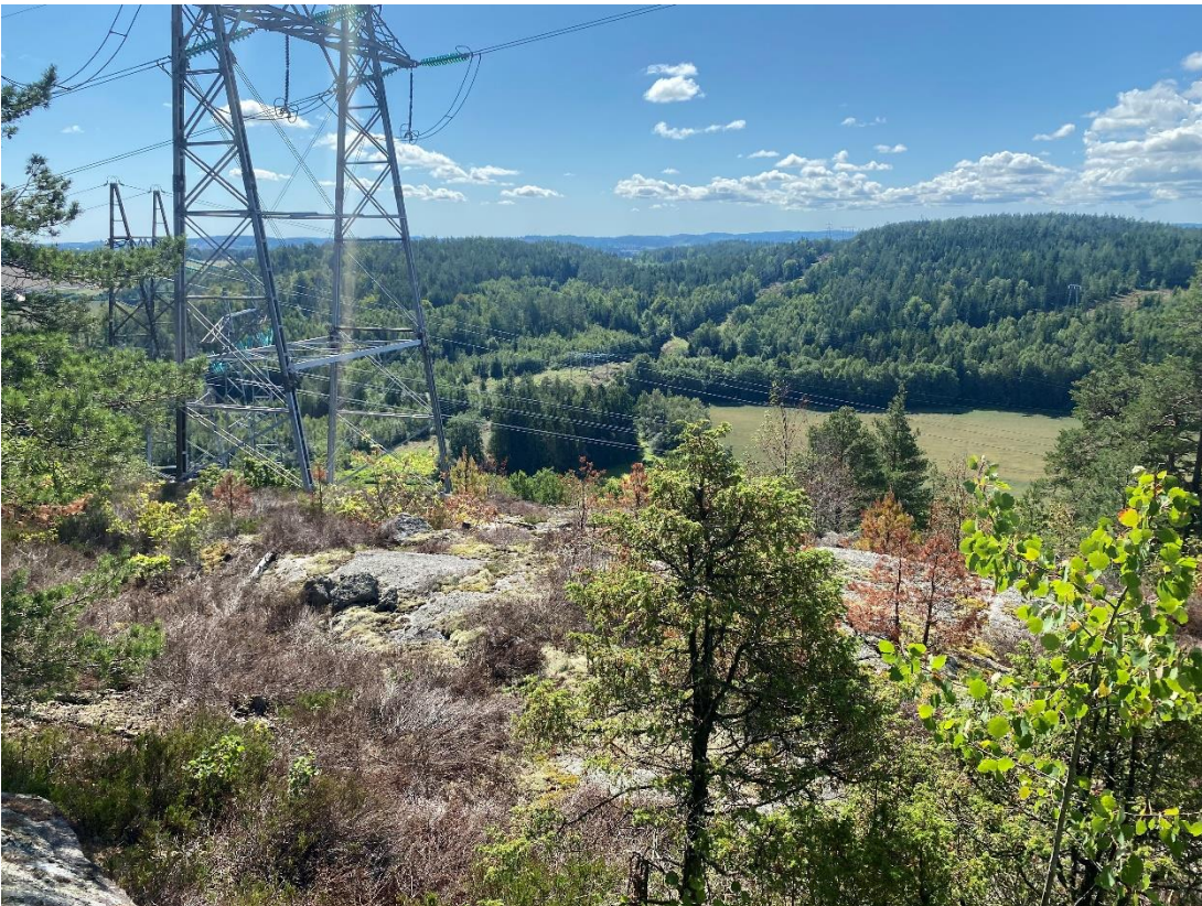
Figur 2-31. Foto fra søndre del av Undrumsdalsåsen mot Gulliåsen i bakkant. Bildet er tatt mot sør med planlagt område for transformatorstasjon midt i bildet i bakgrunnen. Foto: Sweco Norge.
