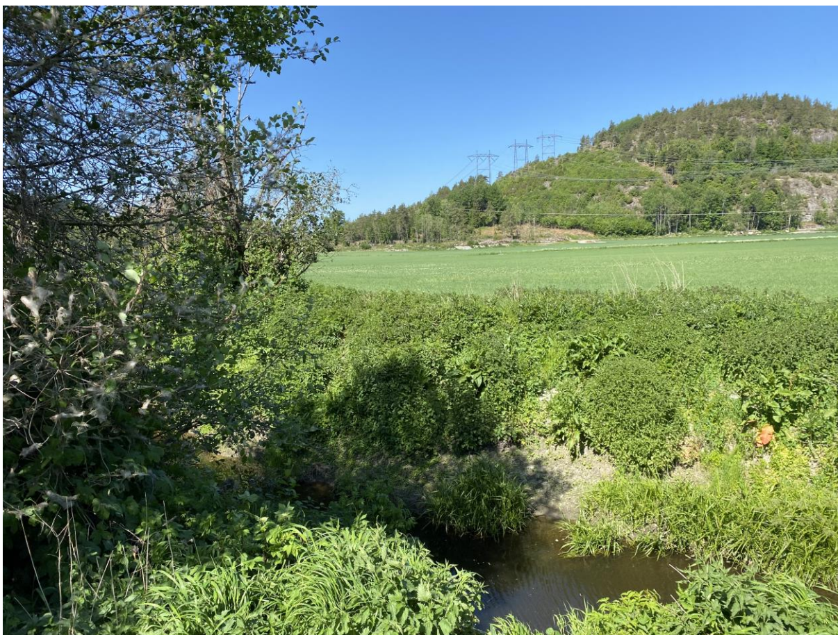
Figur 5 Master og linjer som skal rives. Erstattes med en mast, og nye ledningsinnføringer, som vist i søknadskartet i vedlegg 1. Undrumsåsen i bakgrunnen.
