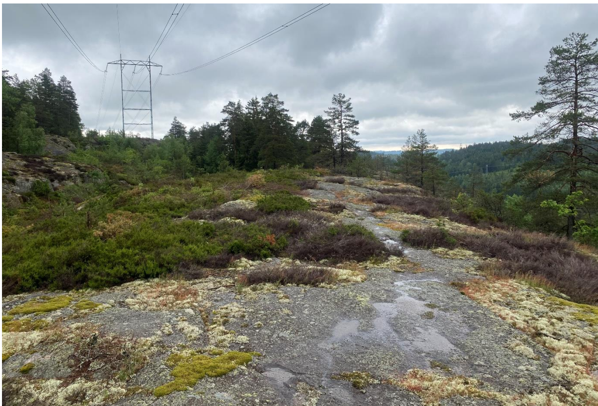
Figur 22. Område for etablering av ny mast og liten riggplass ved Høiås. Foto: Sweco.
