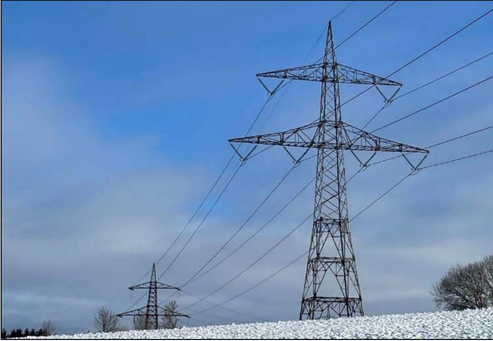
Figur 1-3. Bilde av dobbeltkursmaster i stål fra Nord-Jæren. Foto: Statnett.
