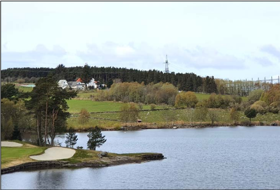
Figur 6-13. Utsikt fra golfbanen ved Stora Stokkavatnet mot eksisterende 300 kV kraftledning (som skal legges om) og koblingsanlegget (som skal legges ned) på eksisterende Stølaheia transformatorstasjon (t.h.) og skogsområdet hvor nye Krossberg transformatorstasjon planlegges bygd (i bakgrunnen t.v.).
