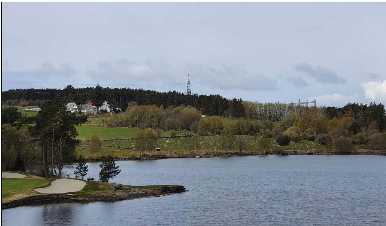
Figur 5-9 Deler av eksisterende Stølaheia transformatorstasjon samt eksisterende kraftledningsmast sett fra området ved golfbanen. Tiltaksområdet er lagt til skogen i bakkant av de hvite husene og kraftledningsmasten, og store deler av denne må hugges i forbindelse med tiltaket.
