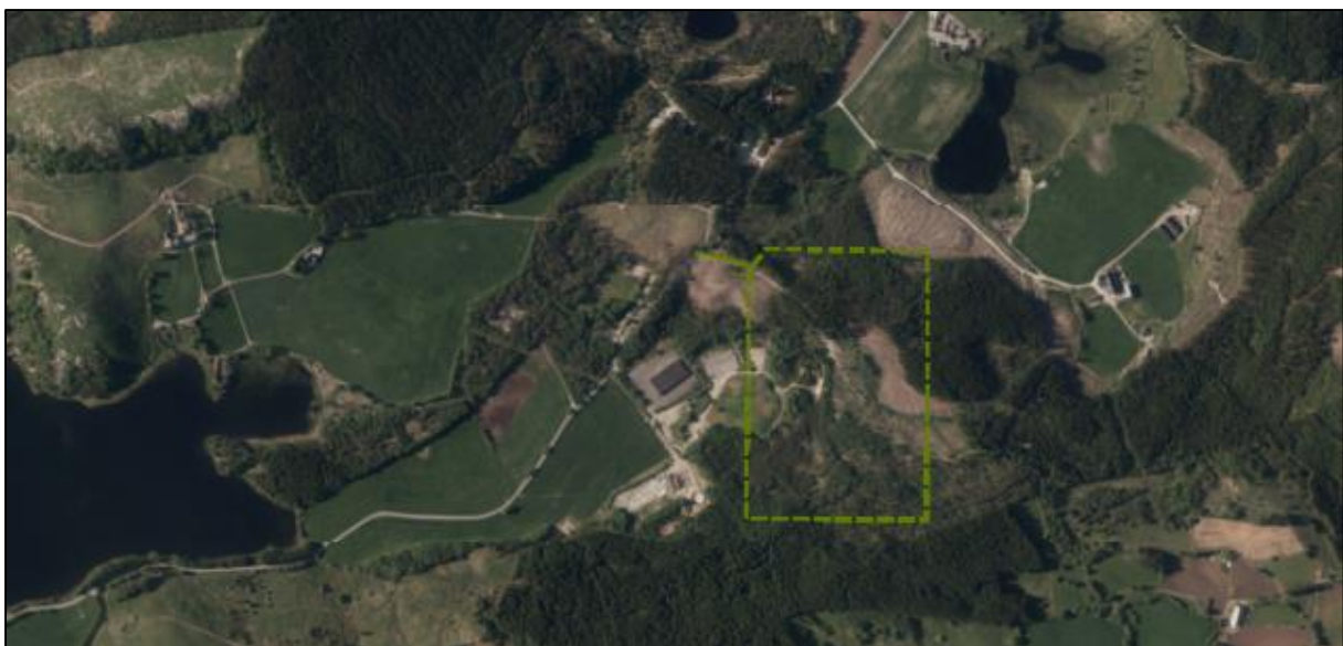
Figur 3-16. Området for Espeland transformatorstasjon, med adkomstvei og transformatorstasjonsområdet.
