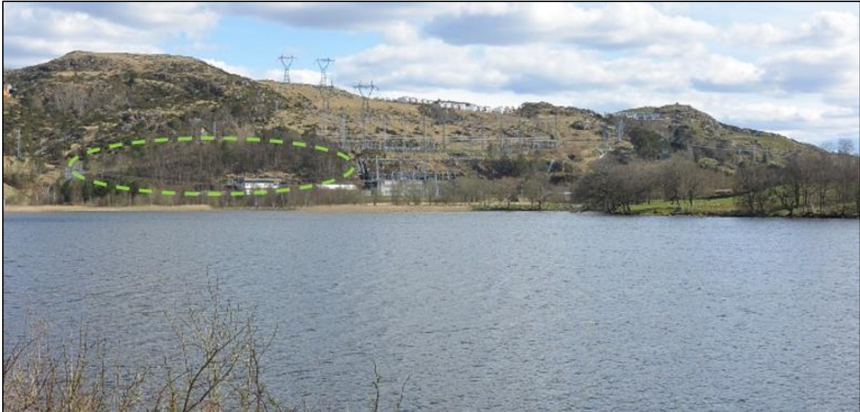
Figur 3-24. Området for påhugg nord for Bogafjell fjellhall transformatorstasjon sett fra Ganddal.
