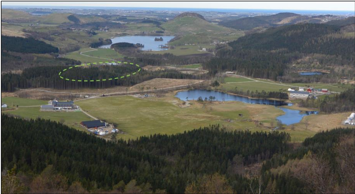
Figur 3-17. Området for Espeland transformatorstasjon sett fra Nutane mot vest, med Bråsteinsvatnet og Bråsteinsåsen i bakgrunnen og Espelandstjørn i forgrunnen til høyre.
