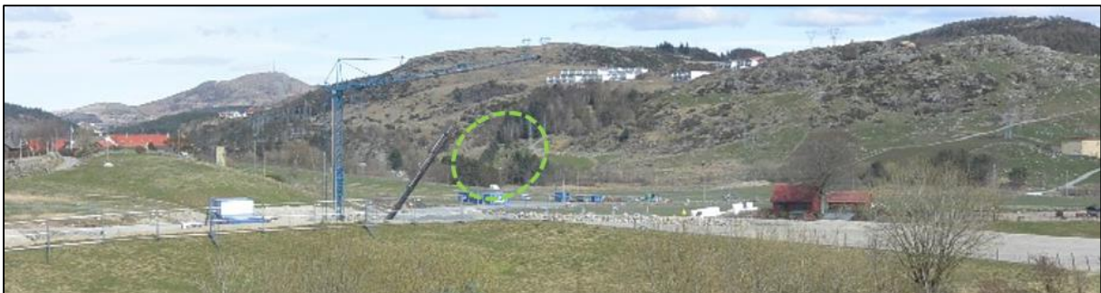
Figur 3-25. Området for påhugg vest for Bogafjell fjellhall transformatorstasjon sett fra Vagleskogen.
