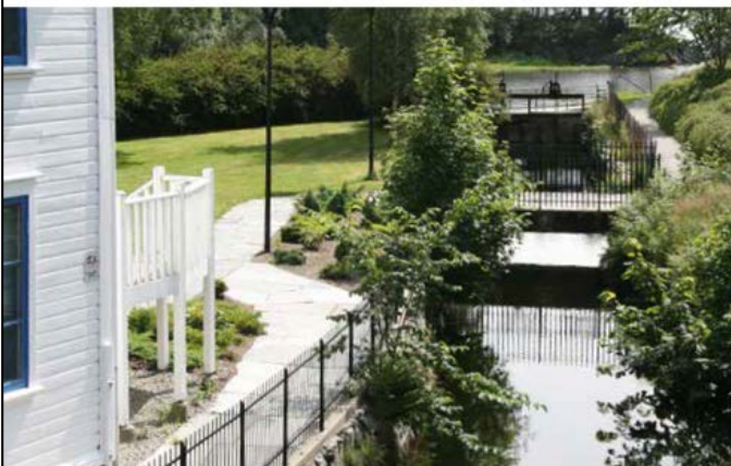
Figur 3-81 Dieselhus fra 1892 og kraftverk og kanal fra 1912 som munner ut i Edlandsvatnet. Foto hentet fra Gjesdal kulturminneplan.
