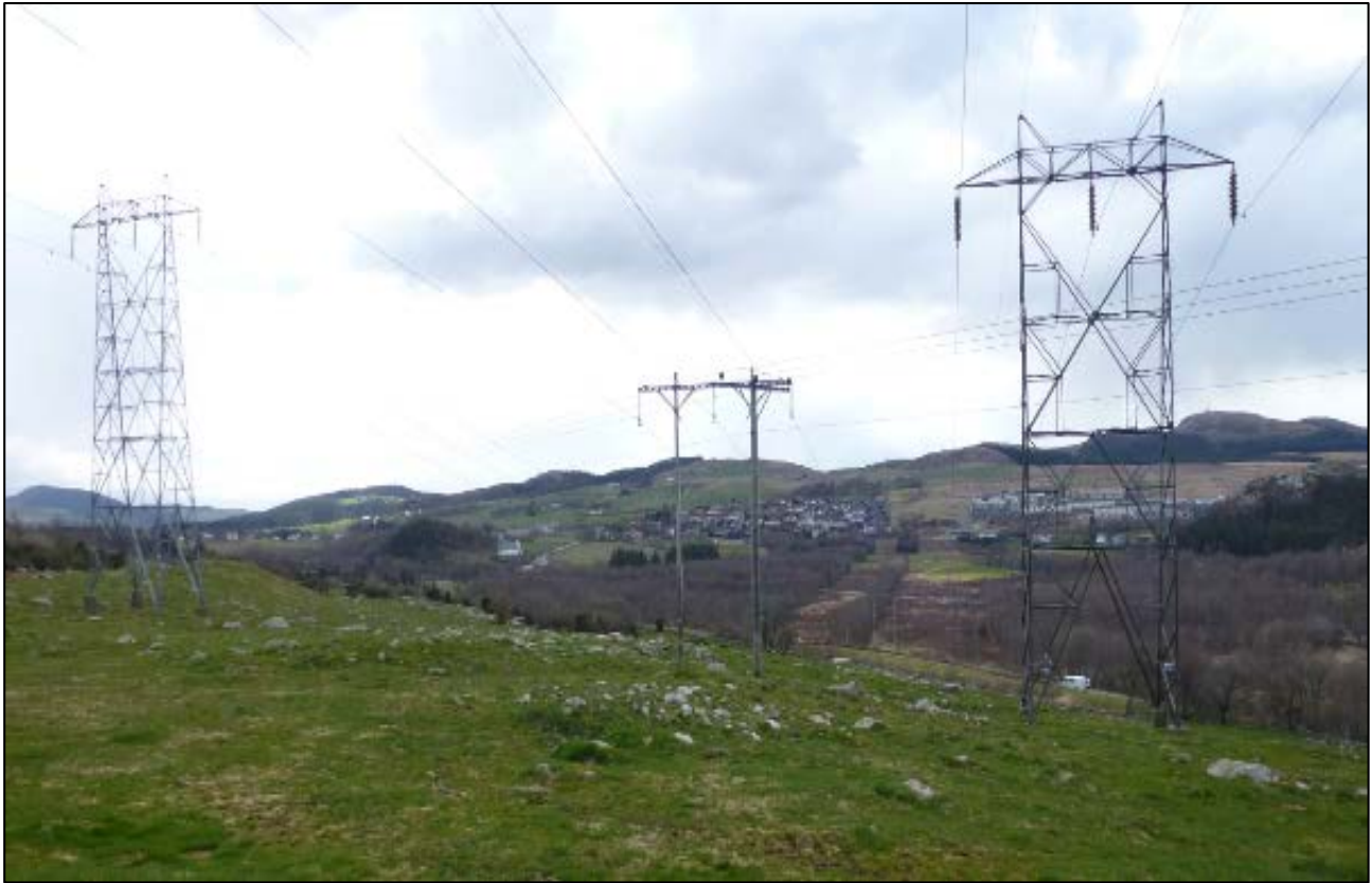
Figur 3-20 Gårdsanlegg, Askeladden id 14977 som ligger rett under eksisterende kraftledninger. Foto: V. Berge, Multiconsult ASA.
