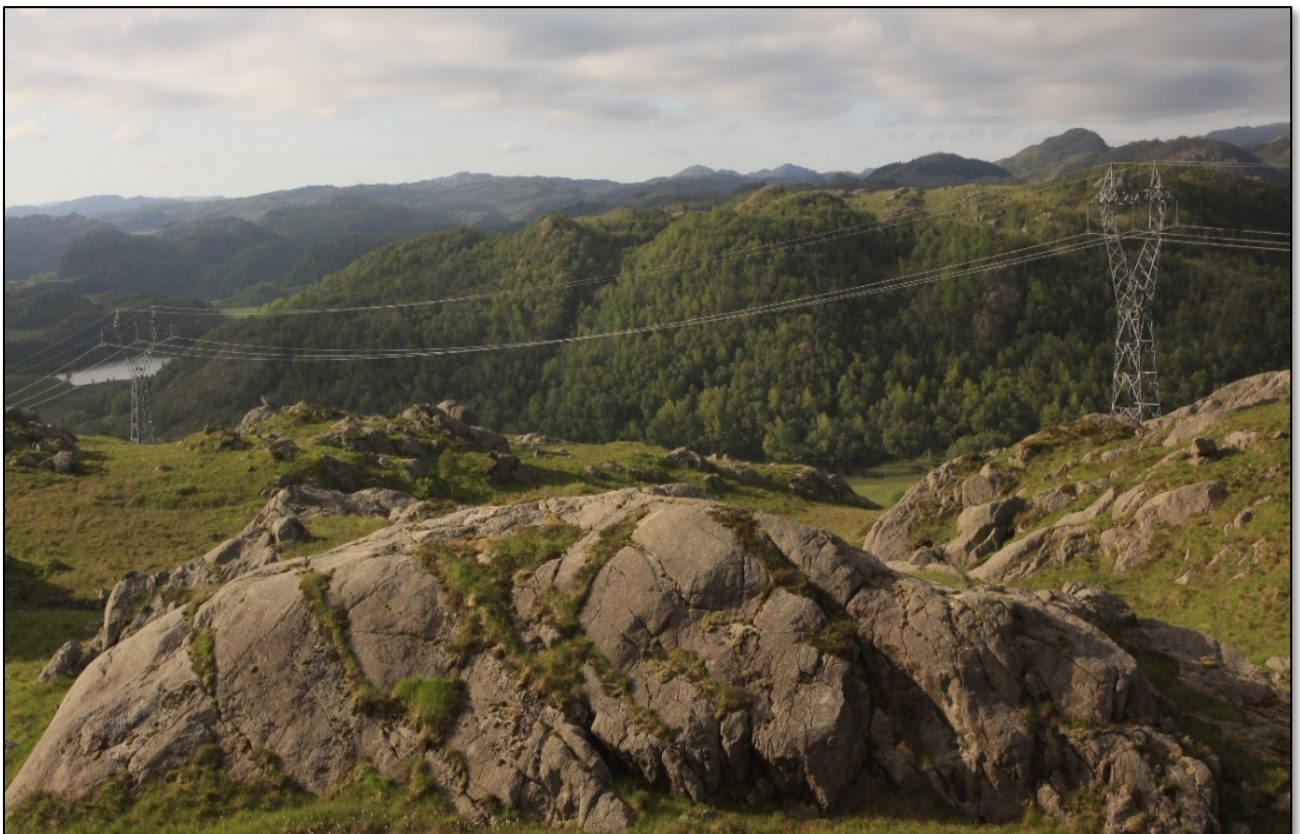
Figur 3-1. Eksisterende 300 kV ledning ved Tindafjellet. Denne kraftledningen vil bli sanert dersom det blir aktuelt å bygge Espeland transformatorstasjon med tilhørende omlegging på Tonstadledningen mellom Kyllingstad og Espeland.
