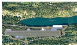
FERDIGSTILT Kvinesdal transformatorstasjon >
