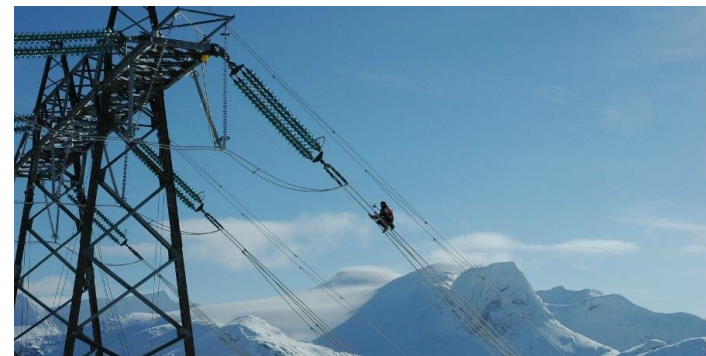
Arbeid med ny 420 kV triplex ledning Lyse-Duge. Gammel ledning rives.
