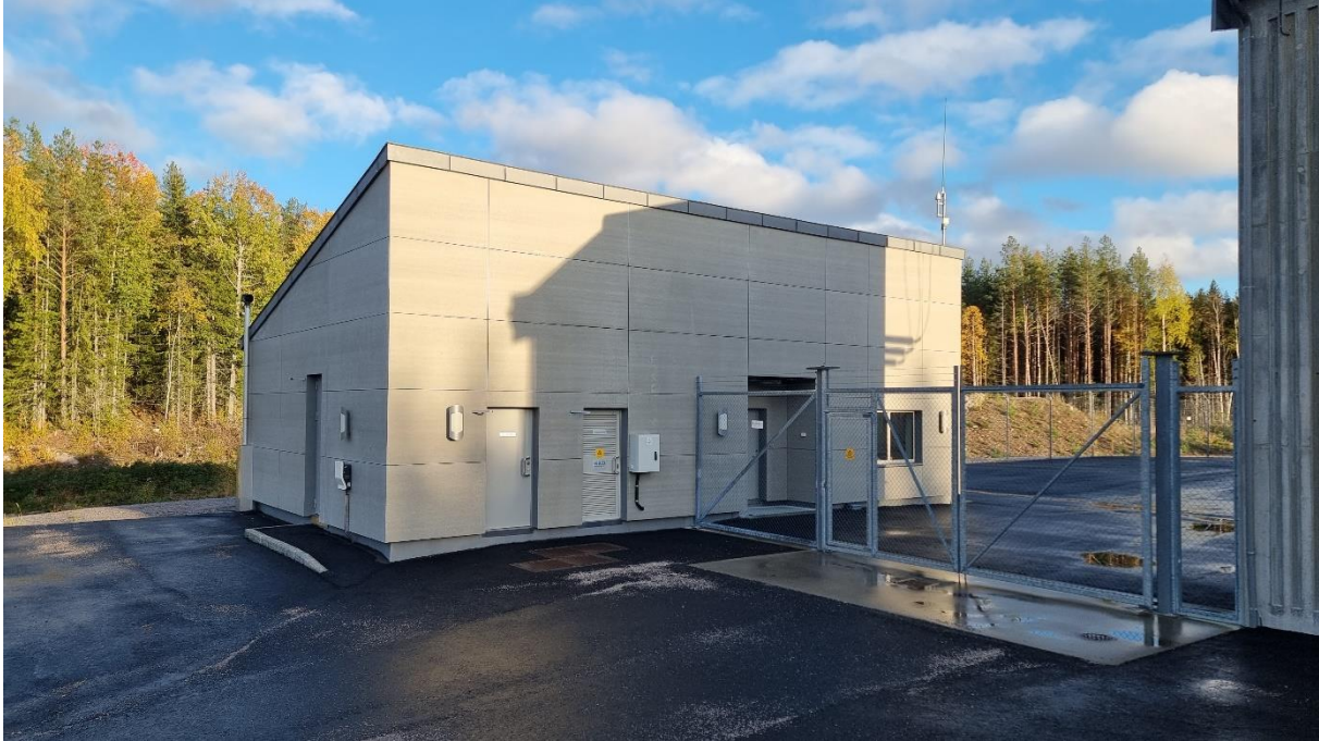
Figur 7: Eksempel på kontrollbygg for Glitre Nett. Her fra Høgefoss transformatorstasjon.
