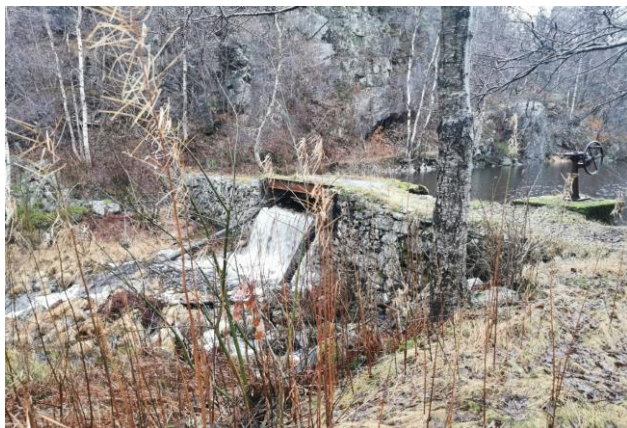
Figur 2-6. Foto av stemme opprinnelig bygget i forbindelse med Høie fabrikker.
