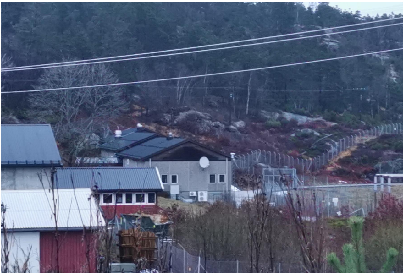
Figur 2-4. Stasjonsbygningen sees med betongkjeller, hovedetasje av prefabrickerte elementer og saltak (nytt i 2001).
