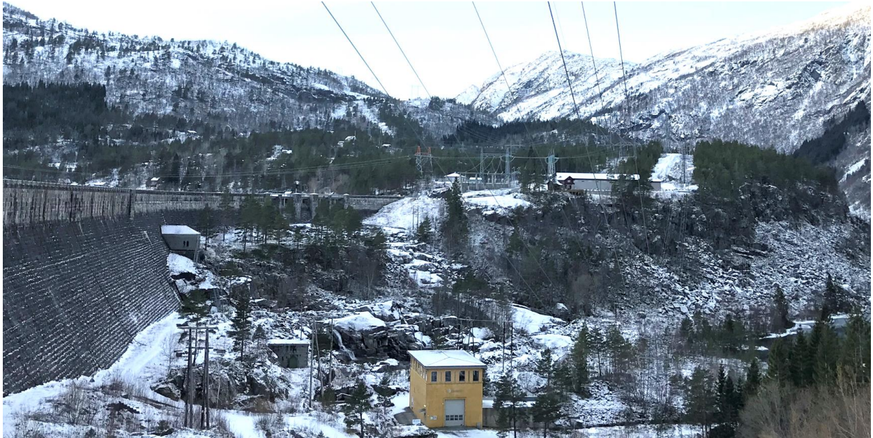
Figur 3: Åsen med eksisterende transformatorstasjonen og hyttefelt. Ringedalsdammen vises til vestre i bildet.
