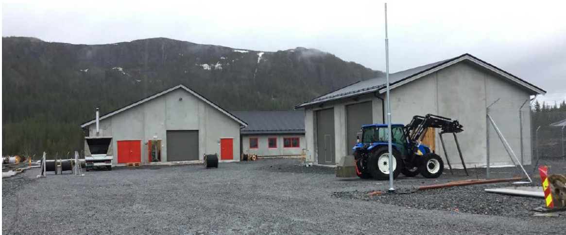
Figur 4: Statnetts standard kontrollbygg og lager/garasje.
