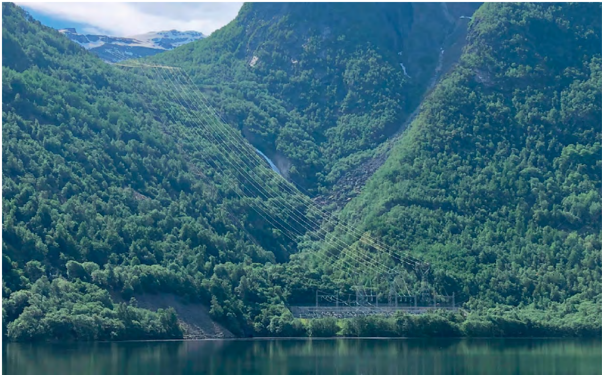
Figur 1: Bilde av dagens Aurland 1 koblingsstasjon, tatt fra nord mot sør. Kilde: søknad Statnett
