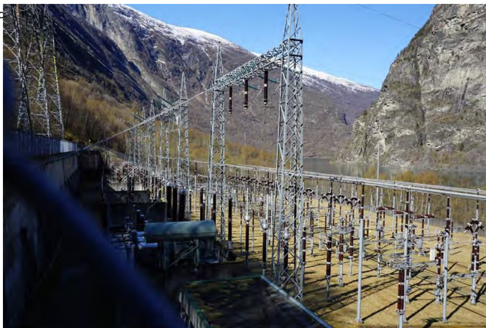
Fra adkomsttunnel mot nordvest
