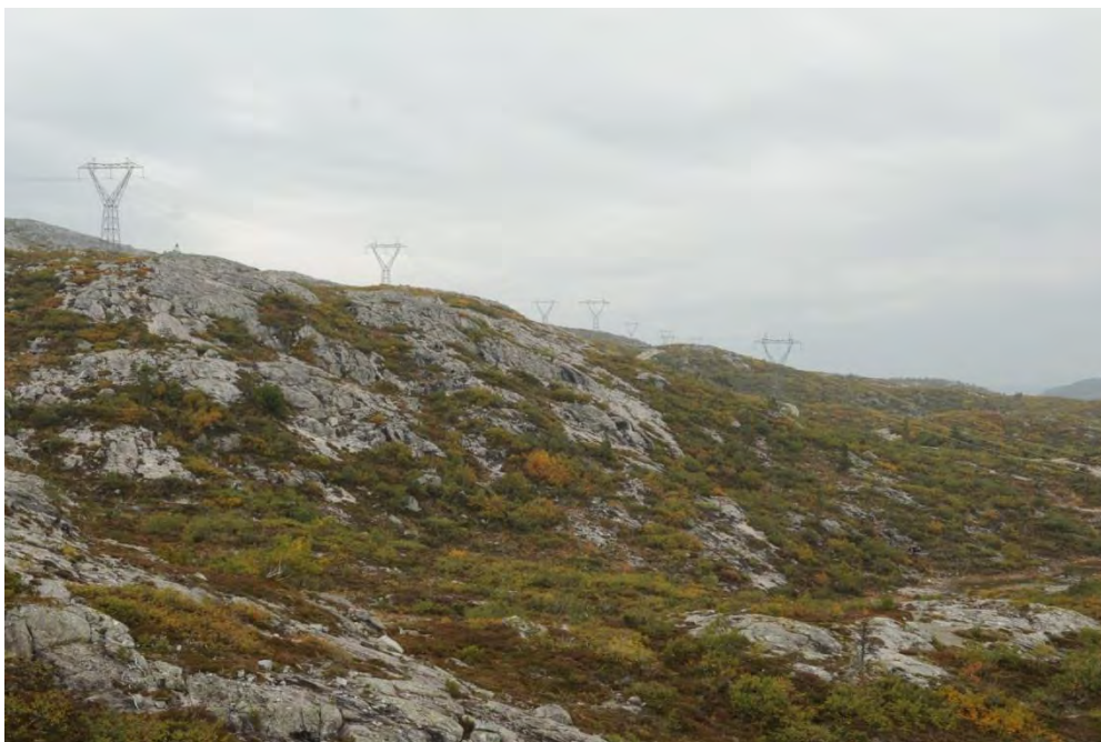
Figur 4-42 Lingesetfjellet på nordsiden av Sognefjorden hvor to ledninger møtes.
