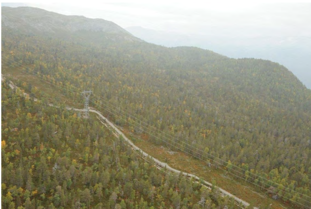
Figur 4-43 Nærbilde av eksisterende ledning sør for Frønningen. Ny trasé vil gå 140 m lenger vest enn eksisterende.
