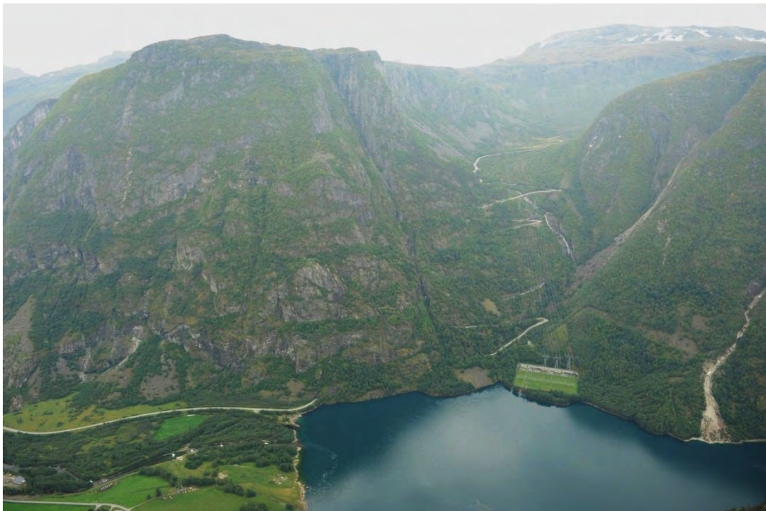
Figur 4-54 Vassbygdi og fylkesvei 50 som slynger seg ned Låvisberget med Aurland transformatorstasjon nederst ved fjorden.
