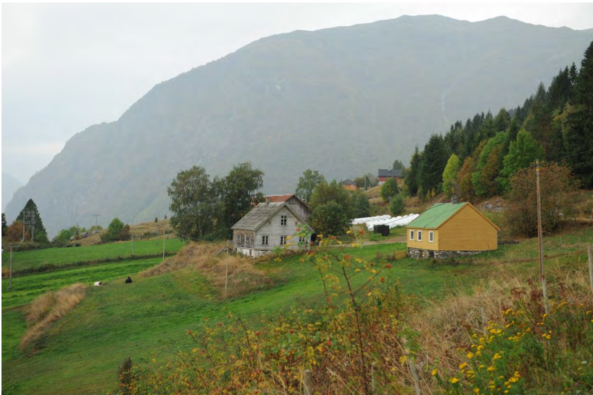
Figur 4-27 Foto fra Øyre i retning ny ledning alternativ 1b. Spennbukkene blir liggende nedenfor synsfeltet i bildet, ca 50 m lavere enn gården men spredemastene på oversiden av veien vil bli synlige i grenda.
