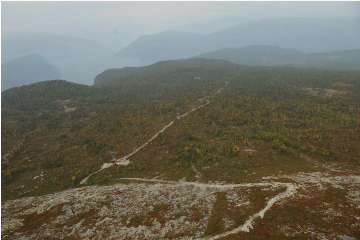
Figur 4-41 Helikopterbilde nordover mot Frønningen langs eksisterende kraftledning.
