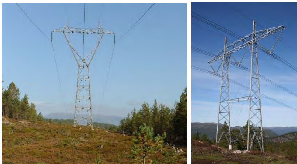
Figur 4-17 Bildet til venstre viser gammel type mast, bildet til høyre viser ny mast
