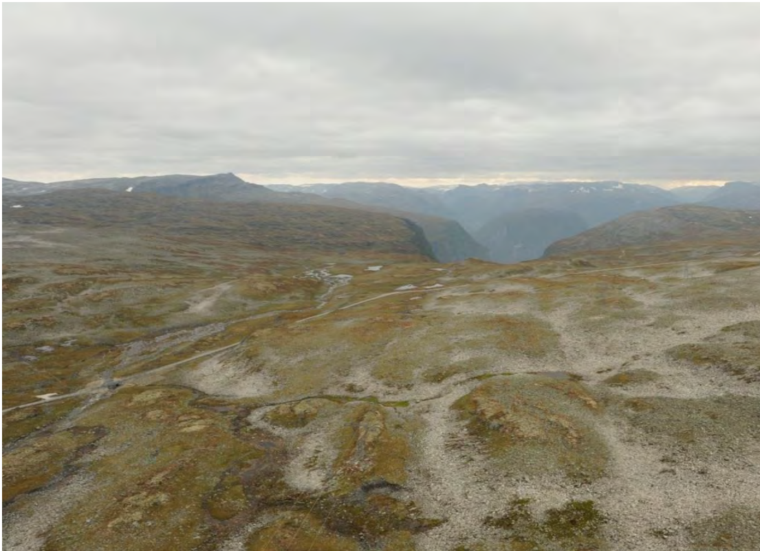
Figur 4-49 Eksisterende ledning er lite synlig i landskapet. Ledningen krysser Aurlandsvegen i bildet.
