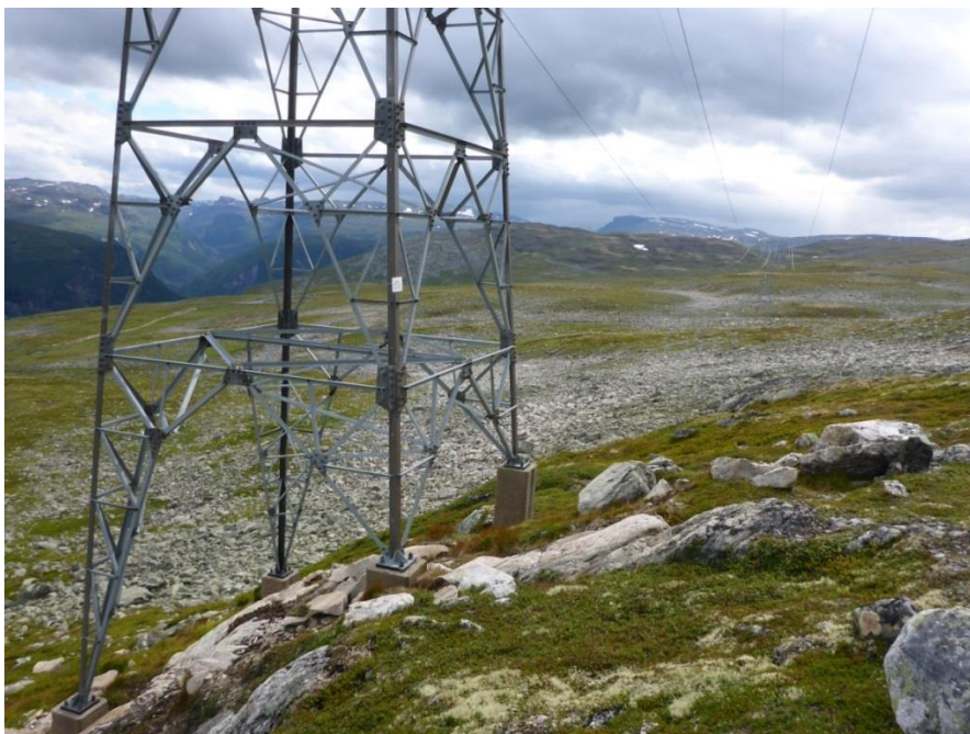
Figur 4-11. Mast der dagens 300 kV krysser fv. 243. Bildet tatt mot syd mot Aurland. Vi ser at mastefestet gir svært lite skade på vegetasjonen, noe som er typisk for fjellfundamenter.
