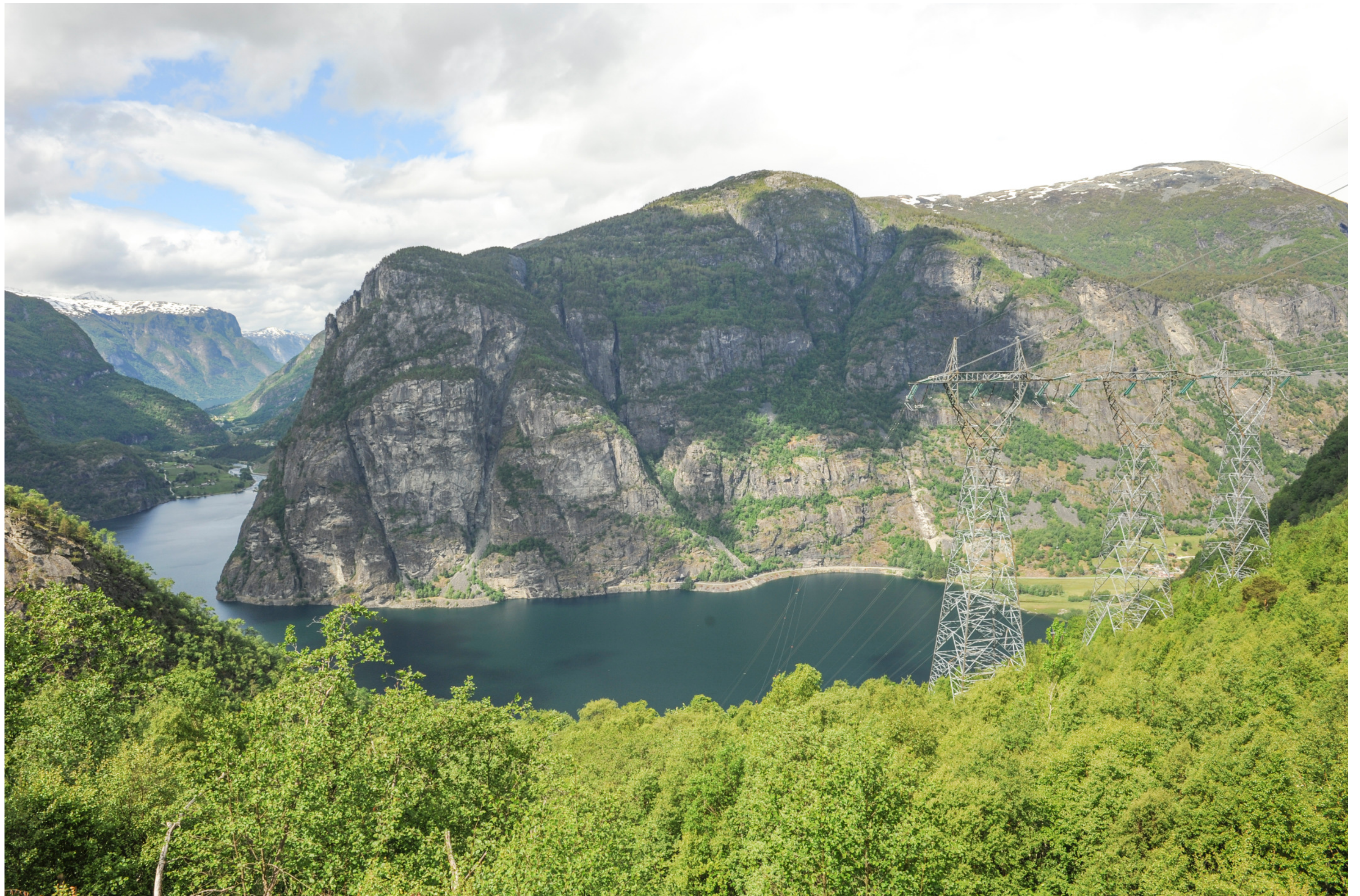
Vassbygdatnet fra Fv 50, dagens situasjon
