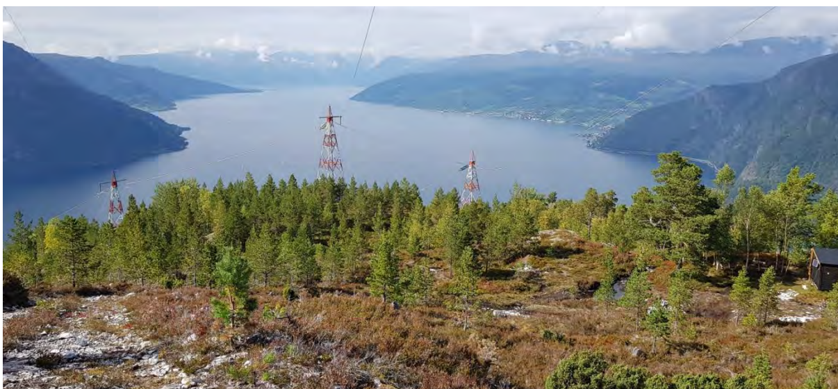
Figur 27 Spennbukker på østsiden av fjorden sett mot vest. Bilde Statnett.
