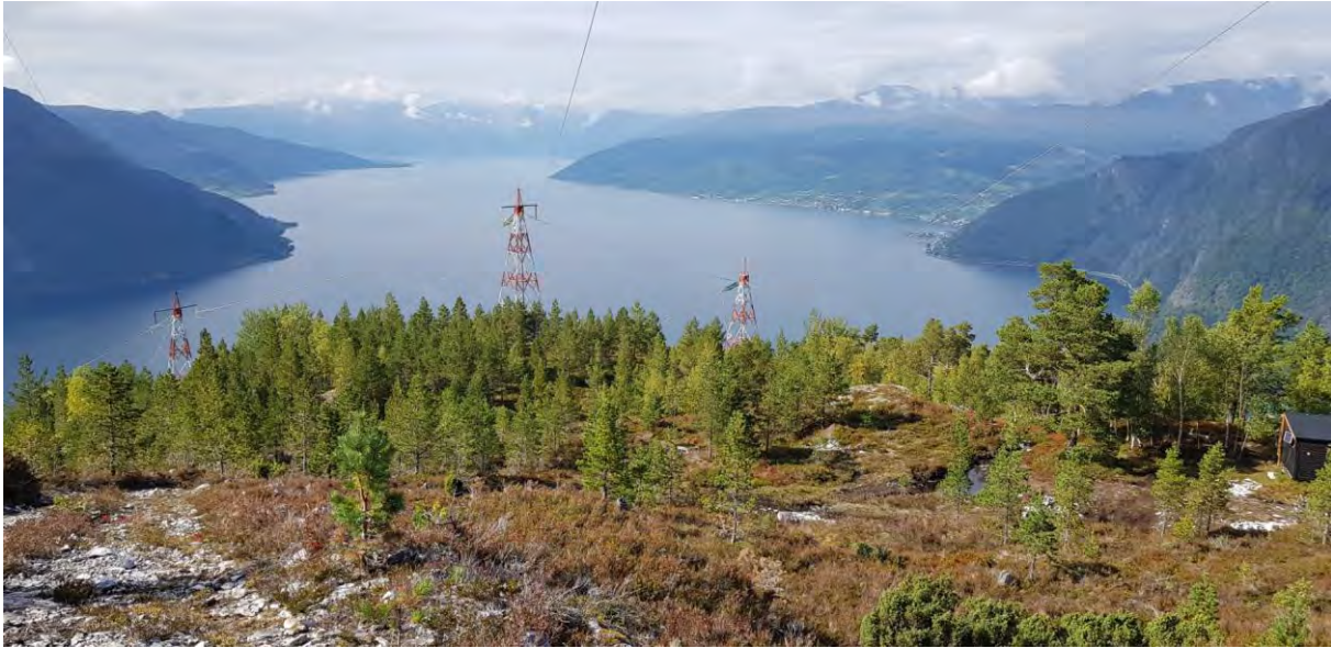
Figur 40 Tre av enfasemastene ved fjordspennet (Bilde: Statnett)
