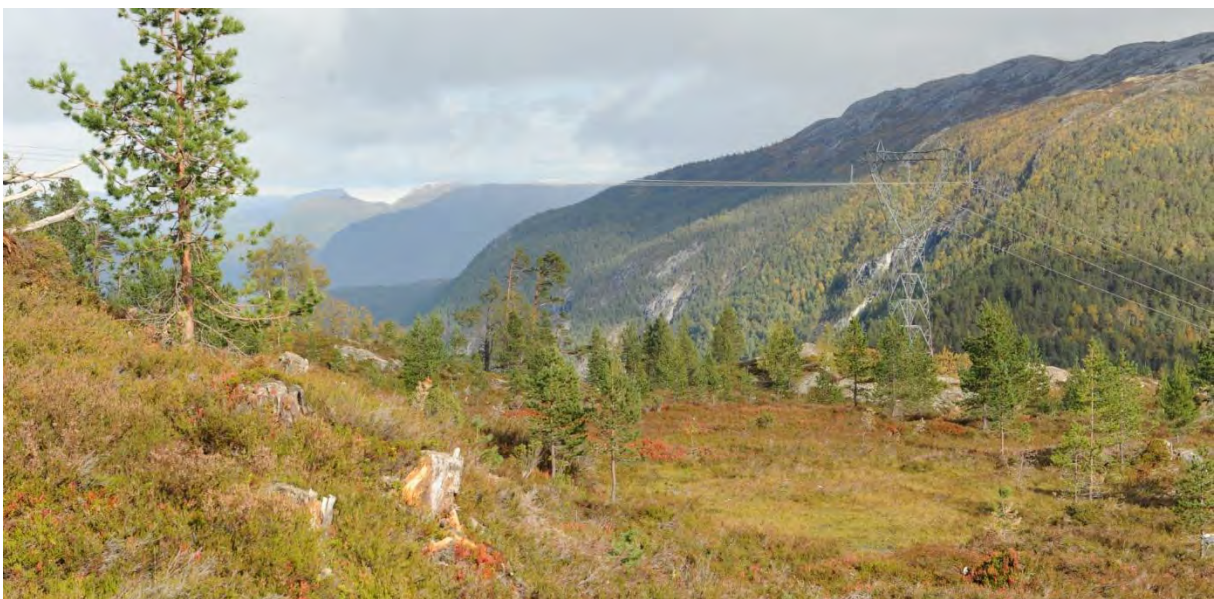
Figur 25 Mastene til eksisterende ledning gjør lite av seg i landskapet når de har bakgrunnsdekning. Bilde: Norconsult
