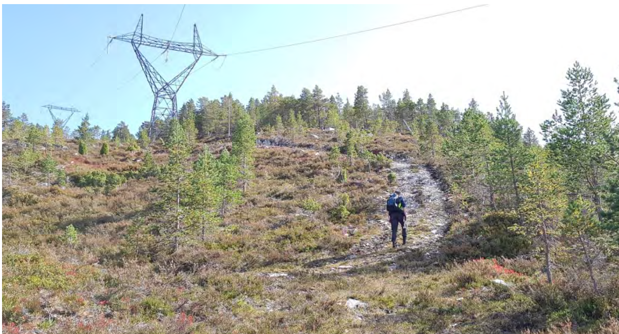
Figur 26 Bilde østover av eksisterende ledning og traktorvei ved Bjørnstigkamben. Foto: Statnett.
