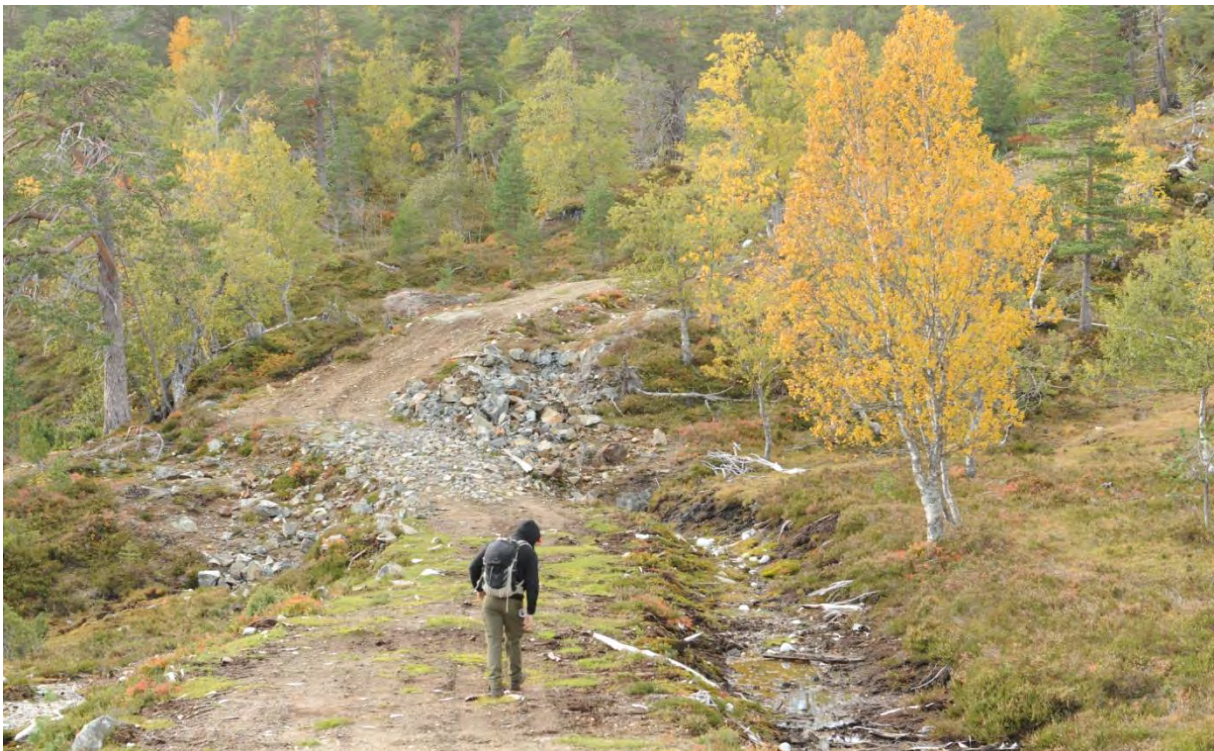
Figur 20 Traktorvei fra Vetlareset mot Bjørnstigfjellet. Veiarbeid ser ut til å pågå uten at arronderingen er avsluttet (september 2014). Bilde: Norconsult
