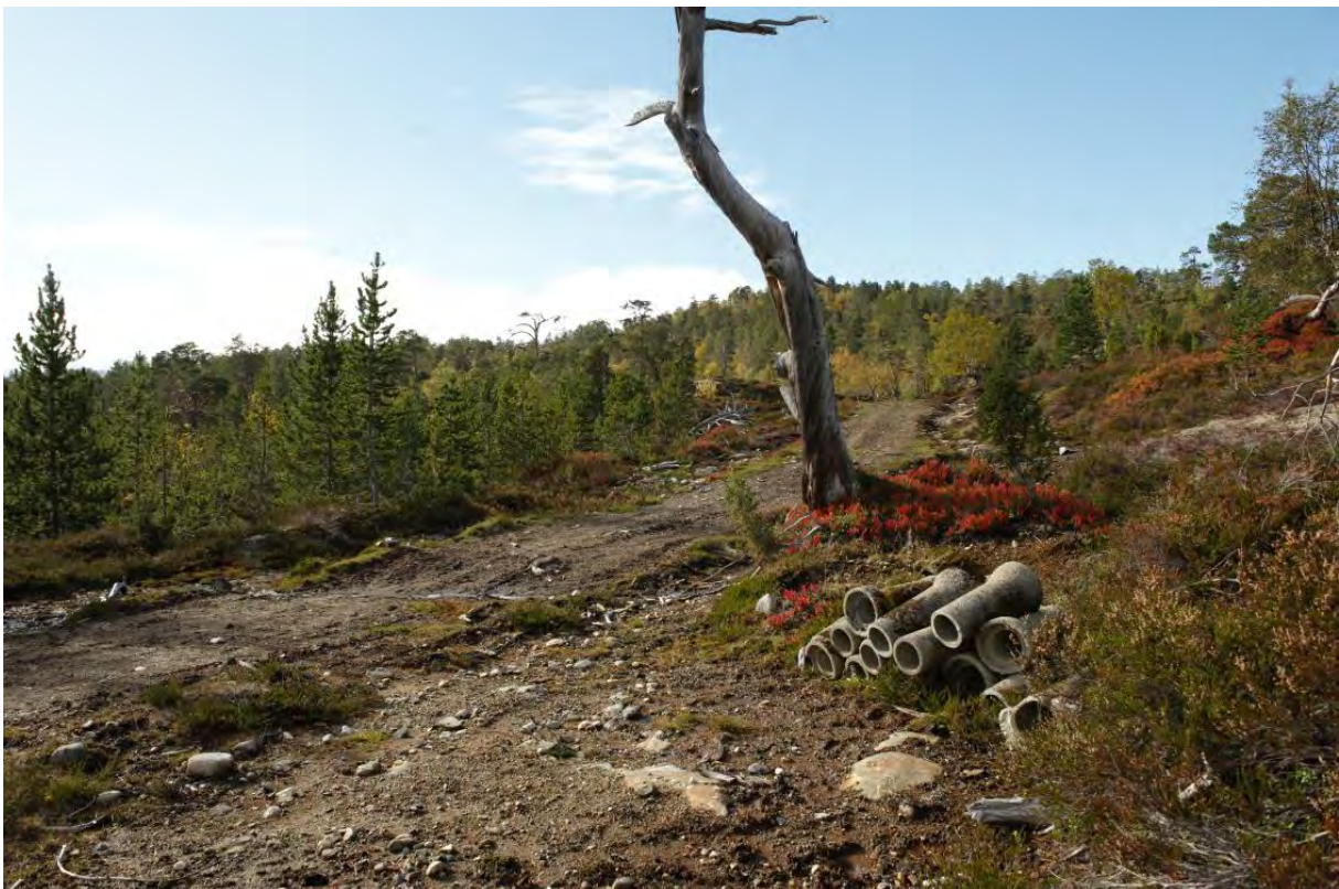
Figur 22 Traktorveien fra Vetlareset til Bjørnstigkamben. Rester etter anleggsarbeid. Bilde: Norconsult
