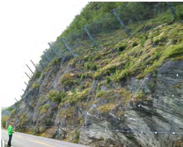
Figur 3. Eksempel på steinsprangggjerde. Kilde: NGI Teknisk notat 20200182-06-TN
