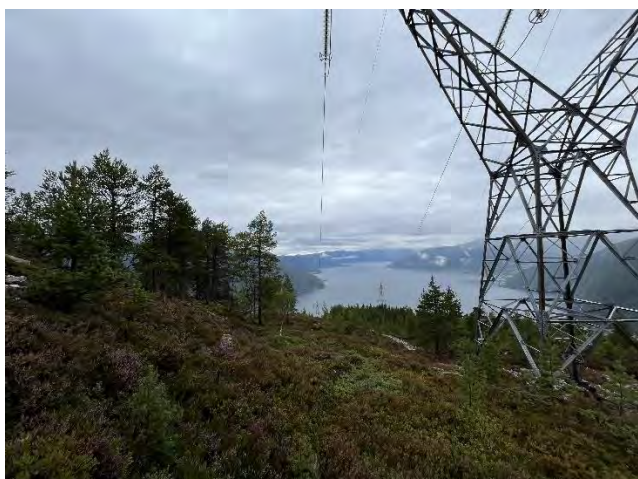
Figur 4-8 Parti fra Fimreiteåsen med eksisterende installasjoner
