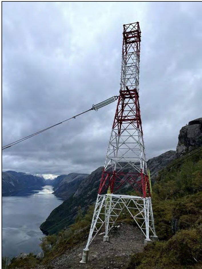
Figur 2-15 Aktuell spennbukk med fundamenter for ny fjordkryssing Tjørnahaugane-Bjørnstigen. Feste av line skjer midt i spennmasta Foto: Statnett
