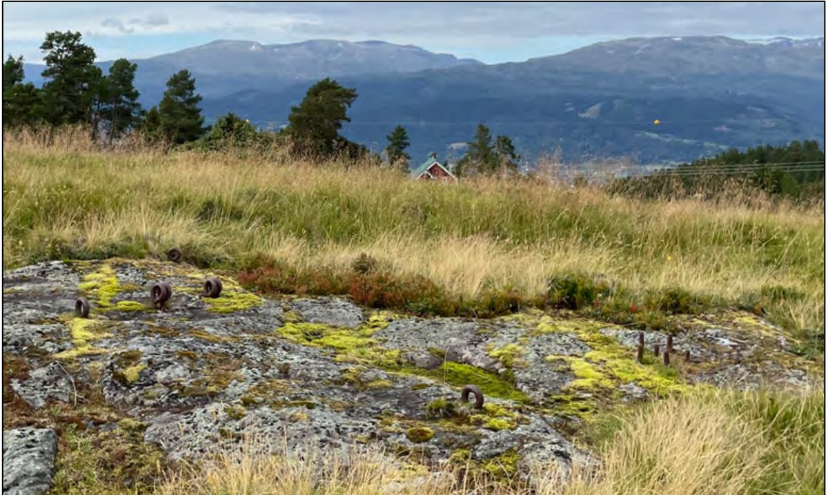
Figur 7-12: Forankringspunkter fra tidligere installasjoner på Ramnaberget, sett mot nord (hytte vest i bakgrunnen).
