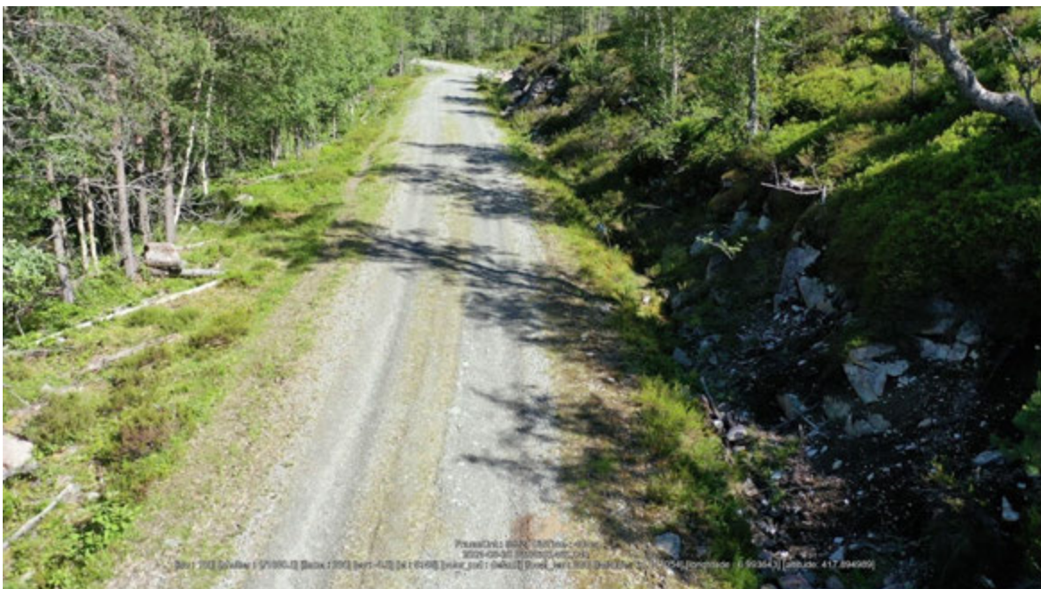
Figur 4. Vei R 10 Fimreiteveien. Planlagte masseuttak MF1 og MF2 på høyre side.
