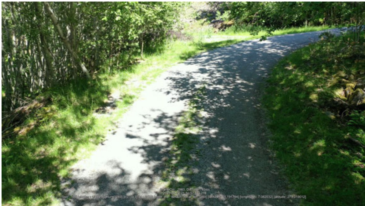
Figur 7. R10 Vinesveien. Hårnålssving rett vest for Brandholten, et eksempel på en strekning der det kan være behov for å øke svingradius og veibredde.
