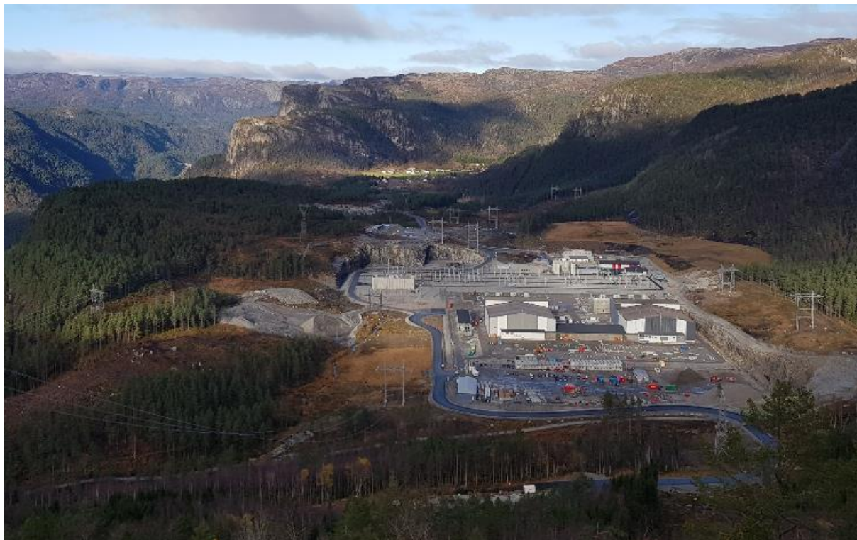
Bilde 2: Ertsmyra transformatorstasjon, NordLink omformerstasjon 1400 MW
