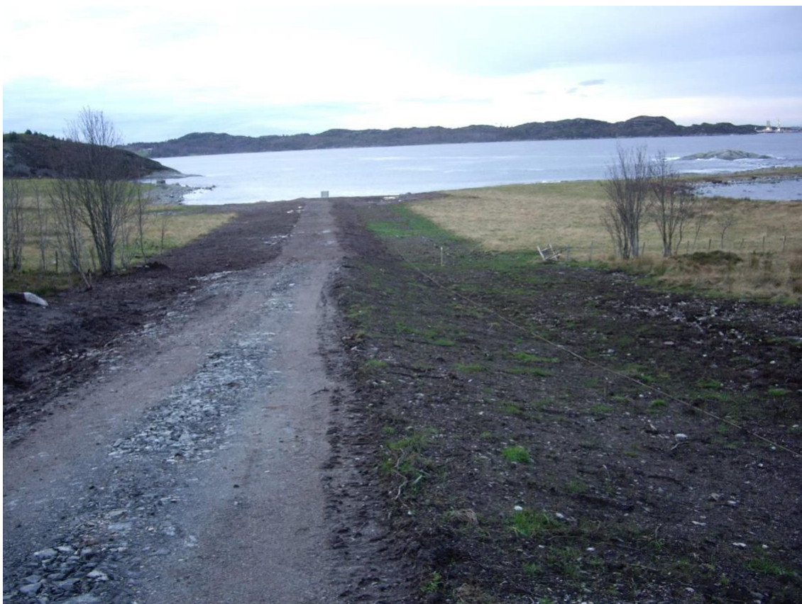
Bilde 5: Jordkabelanlegg etter at kabelgrøft er gjenfylt og terreng reetablert
