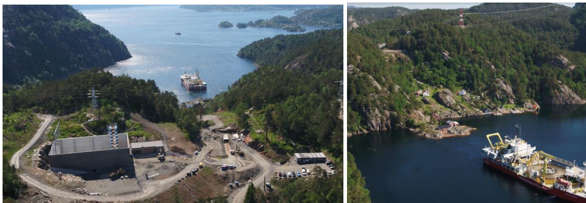
Bilde 3: Vollesfjord muffestasjon, NordLink. 2 stk 400 m lange mikrotunneler med diameter 0,4 m mellom stasjon og ut i sjø
