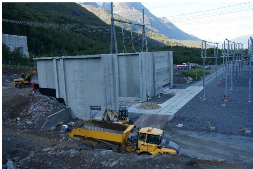
Figur 18: Eksempel på transformatorsjakter i betong.
