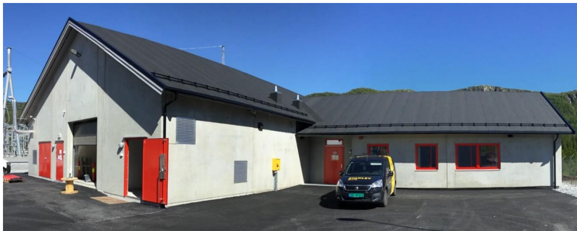
Figur 17: Eksempel på et Statnett standard kontrollhus, her fra Hofstad transformatorstasjon
