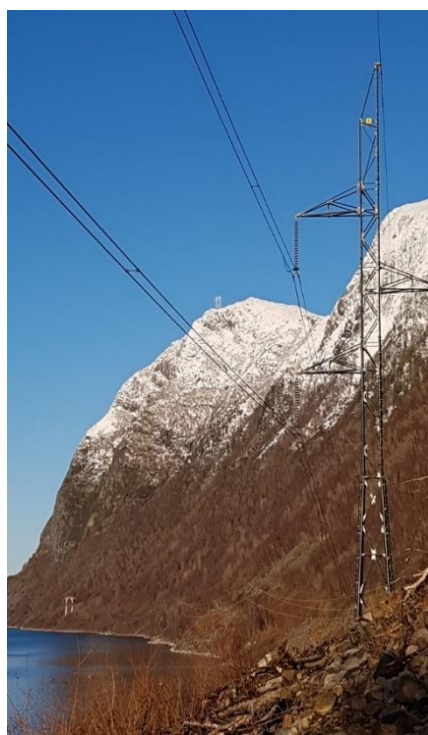
Figur 3: Mast med isolatorkjeder i V-form, og til høyre mast med trekantoppheng. Foto: Statnett
