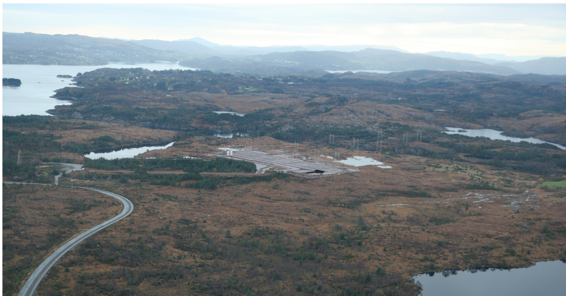
Figur 13. Viser oversiktsbilde fra sør med visualisering av ny transformatorstasjon på Gismarvik, med fire ekstra bryterfelt som utgjør økt omfang av stasjonsområdet sammenlignet med visualiseringer presentert i konsesjonssøknaden fra april 2020. Til venstre i bildet ligger den eksisterende veien i næringsparken som går ned til kaianlegget.
