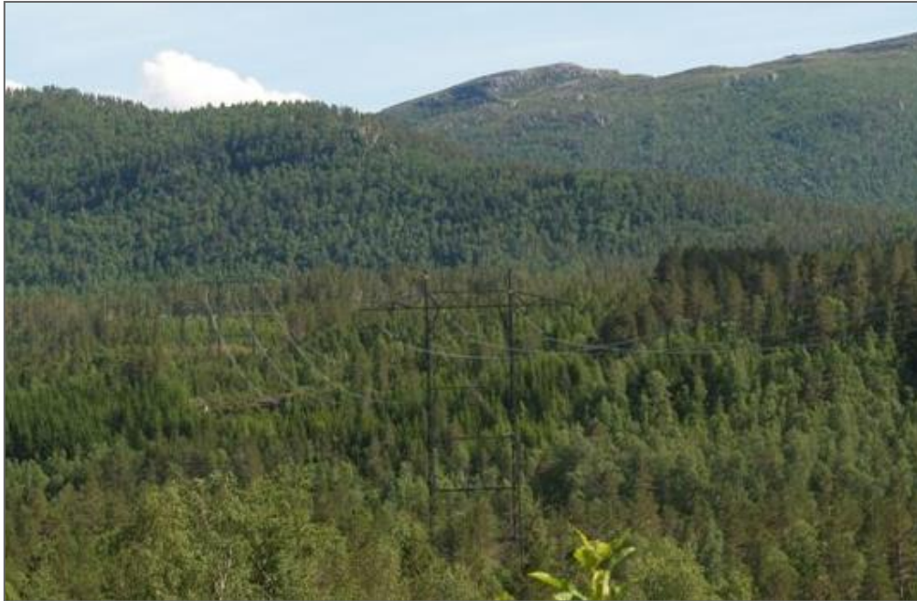
Figur 18: Bilde av kamuflert kraftledning.
