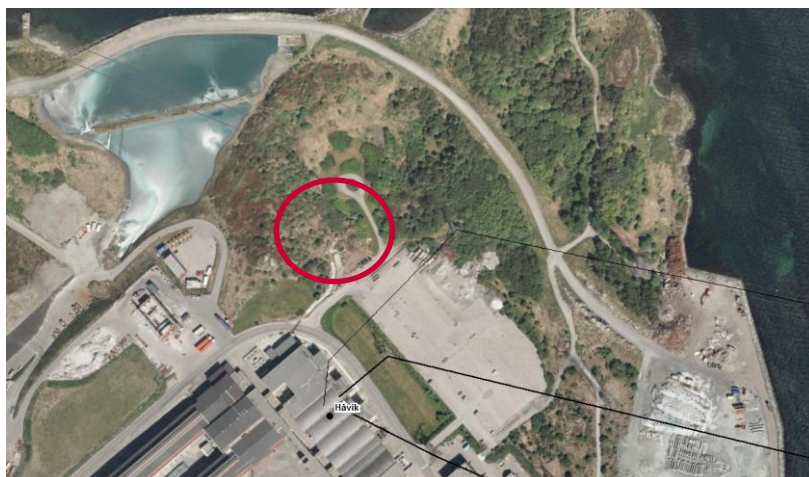
Figur 10: Dagens Håvik transformatorstasjon (innebygget nederst i bildet), mulig område for ny Håvik stasjon (rød ring)
