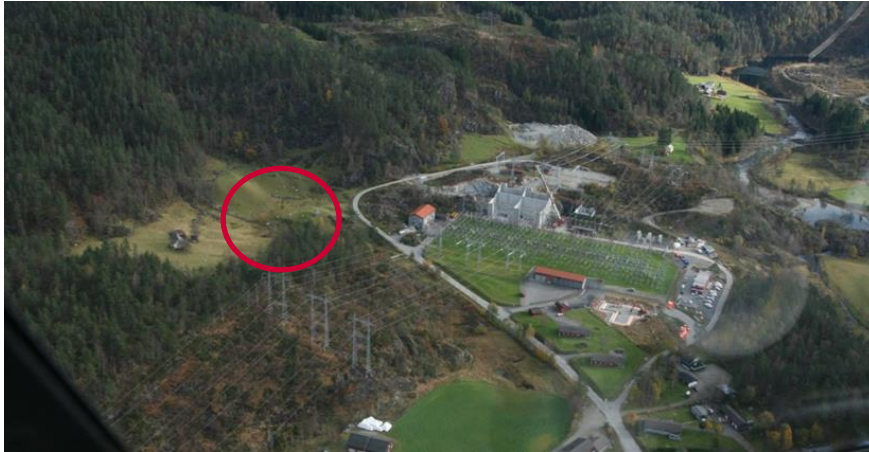
Figur 9: Sauda transformatorstasjon sett fra vest. Nytt 420kV anlegg skal plasseres nord for dagens anlegg, mot venstre i bildet, på motsatt side av veien (rød ring).
