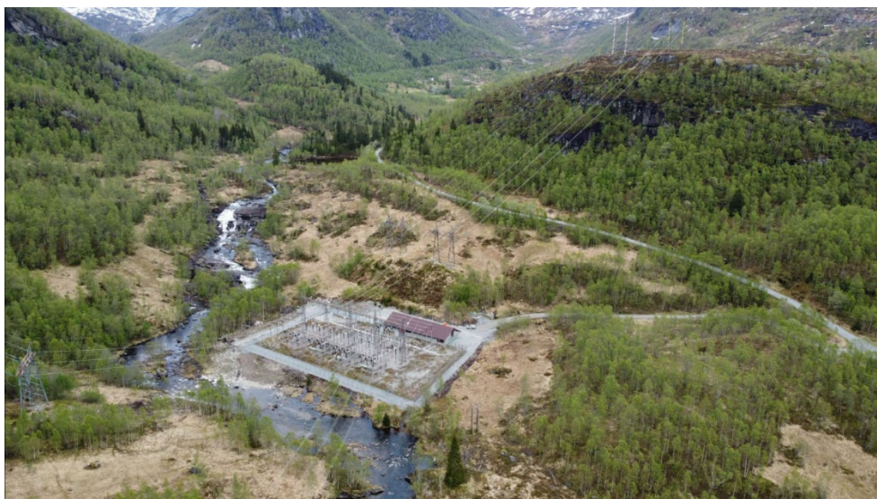
Figur 3: Oversiktsbilde av Modalen koblingsstasjon
