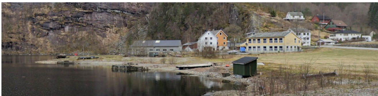
Figur 7: Området hvor det skal etableres kaihakk på Eidslandet. Fylkesvei 569 hvor transformatortransporten skal gå vises i bakgrunnen i bildet.
