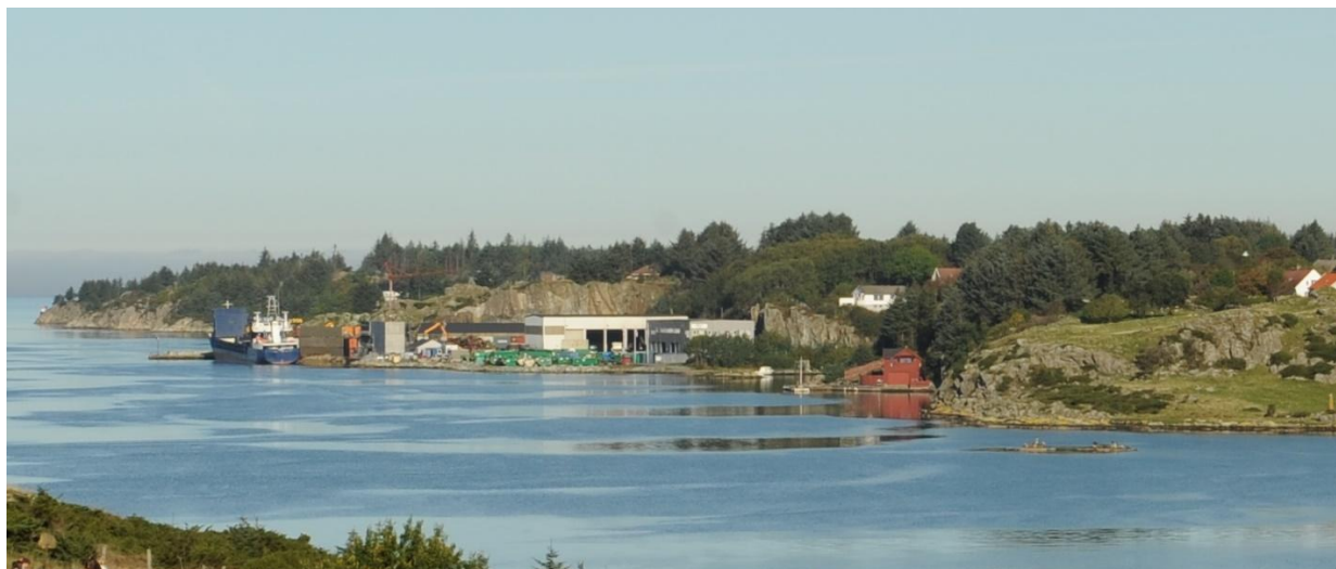
Figur 5-16. Bilde fra Danielsen ungdomsskole mot stasjonslokalitet på Ytraland, ytterst til venstre i bildet.
