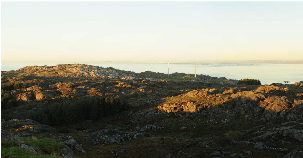
Figur 9-1. Dagens situasjon av transformatorlokasjon, sett fra Børgje.
