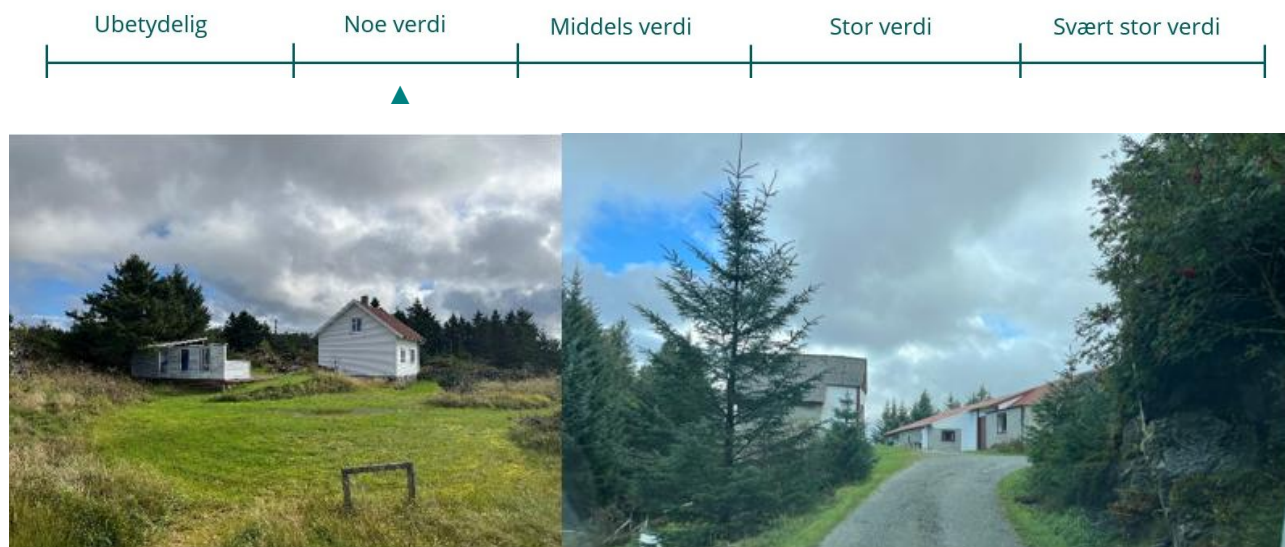
Figur 4-23 Store deler av delområdet har vært endret gjennom tid. Gårdsmiljøet lengst nord i delområdet (til høyre) er betydelig ombygget, bygningene har fått nye bygningsdeler i betong.
