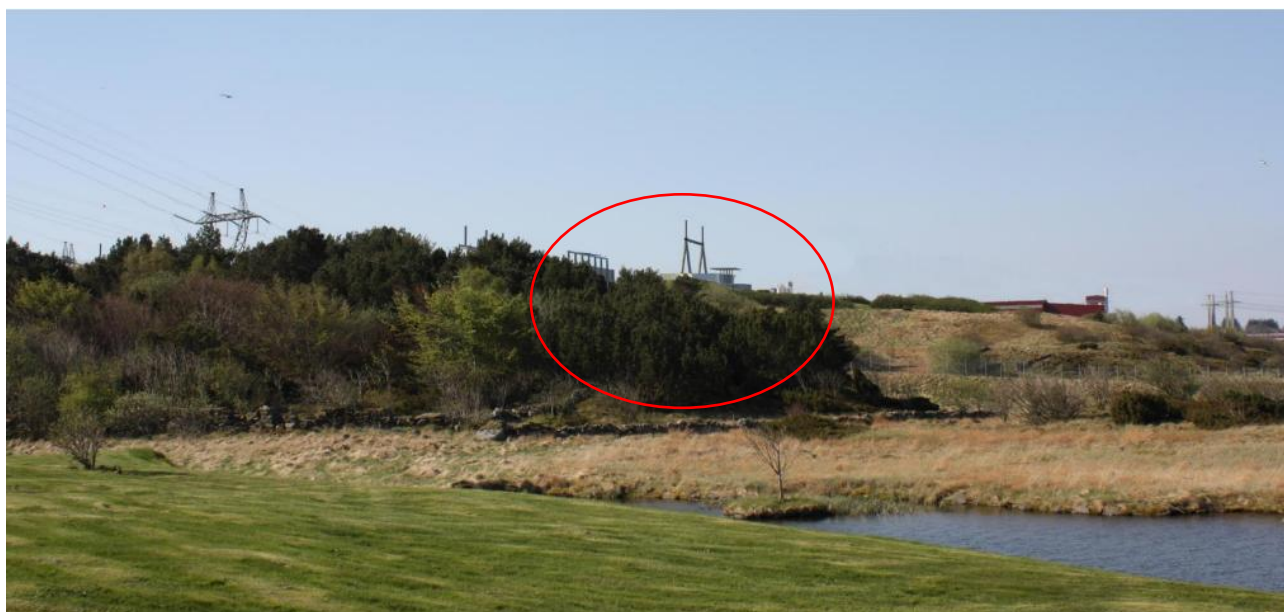
Figur 5-2 Dagens luftledning med Nye Karmøy stasjon (omsirklet) sett fra delområde 1. Kilde: Konsesjonssøknad for Ny Karmøy transformatorstasjon. Visualiseringer er utarbeidet av Sweco.
