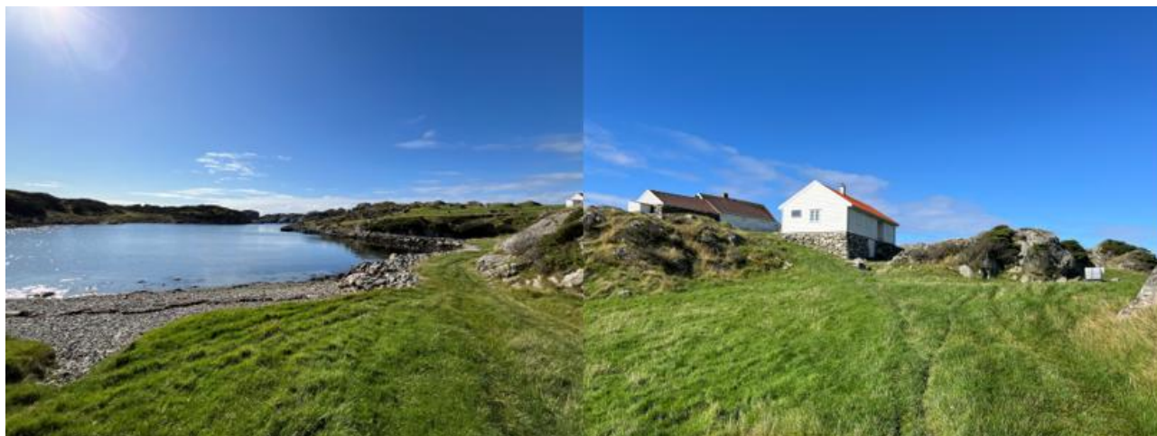
Figur 4-19 Til venstre: Vikavågen og vei til gårdsbygninger. I bakgrunnen til høyre kan en se en godt bevart bakkemur over stranden. Til høyre: fra venstre til høyre: eldhus, våningshus og nyere bolig bygget opp på løes grunnmur.
