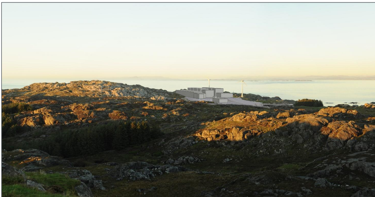
Figur 5-17: Utsikt fra loshytta på Børje i dag (øverst), og illustrasjon på hvordan tiltaket vil se ut etter utbygging av stasjonsanlegg (nederst). Foto fra sør mot nordøst.
