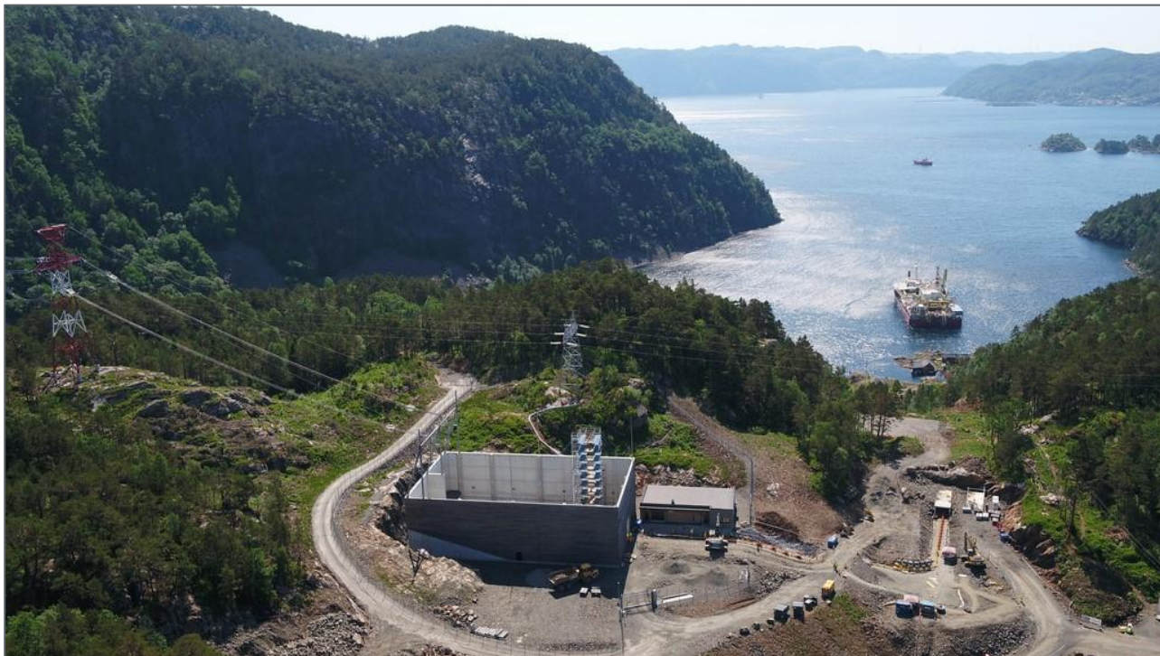
Figur 5-1: Muffestasjon i Vollesfjord under bygging. Hentet fra NVE sine sider.
