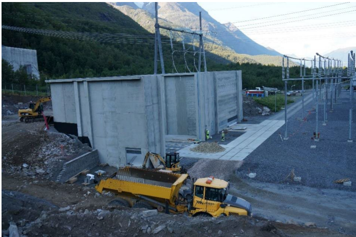
Figur 3: Eksempel på transformatorsjakter i betong
