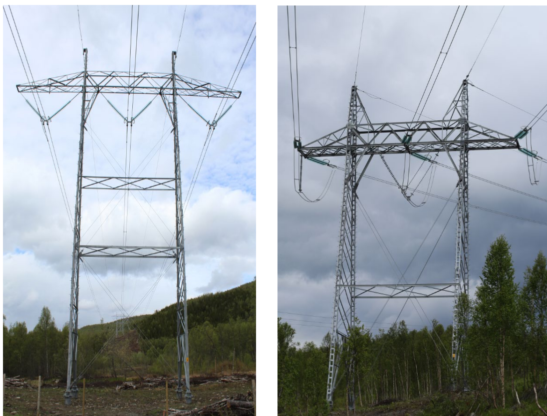
Figur 4: Illustrasjonsbilder av Statnetts 420 kV portalmast. Bæremast til venstre, forankringsmast til høyre.
