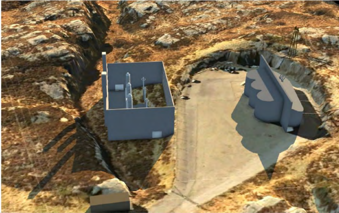
Figur 2 Visualisering av muffestasjoner på Nordre Blomøy. Dagens muffestasjon til høyre. Ny muffestasjon til venstre. Kilde: Statnetts søknad
