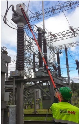
Bruk av kamera med isolerstang.
